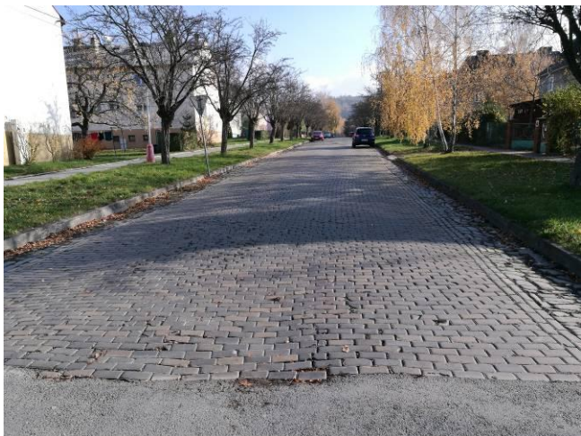
dlážděná komunikace Gen.Eliáše– pohled od Olomoucké
