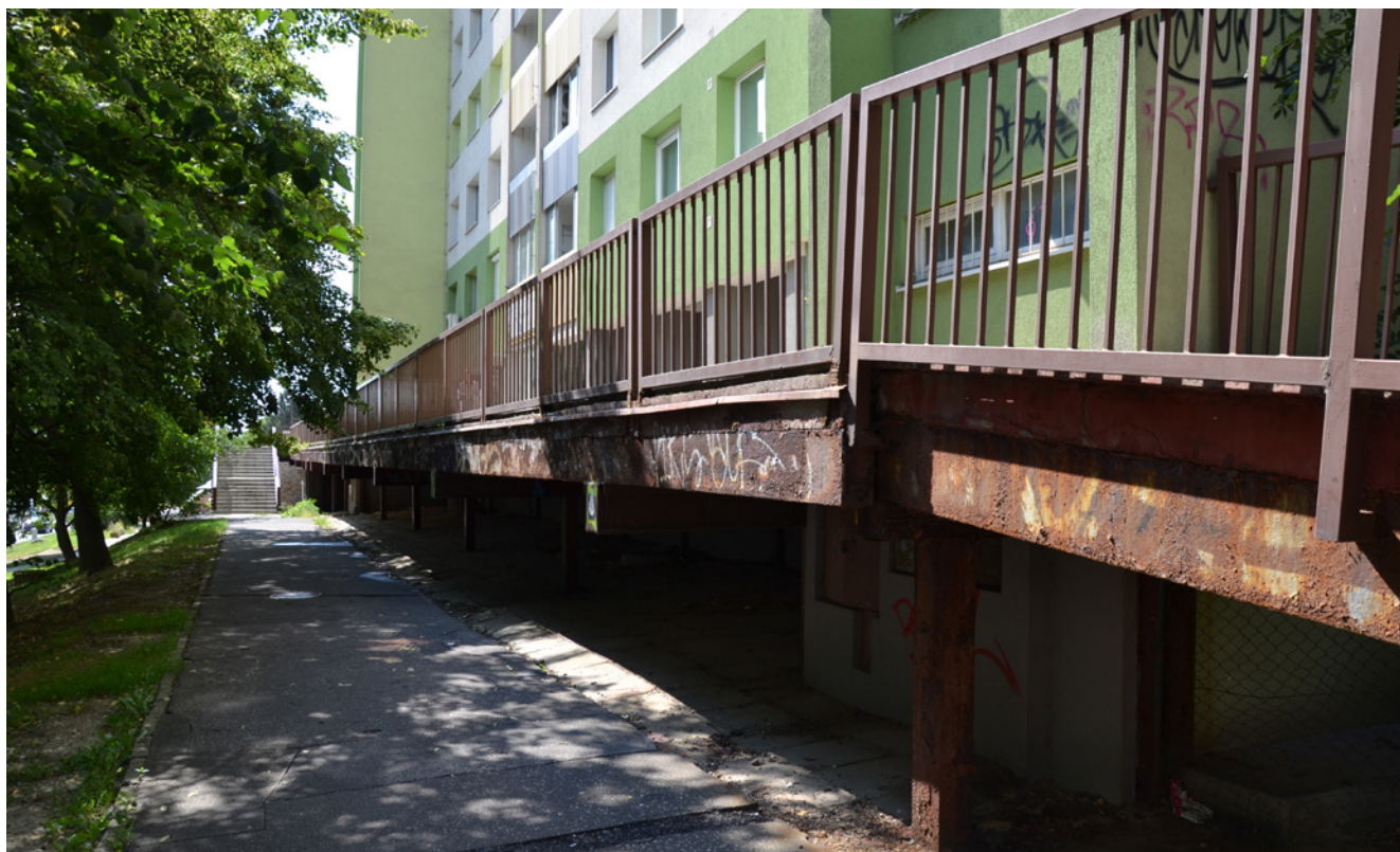
Rampa a vstupy do bytového domu – Jurigovo námestie č. 3
