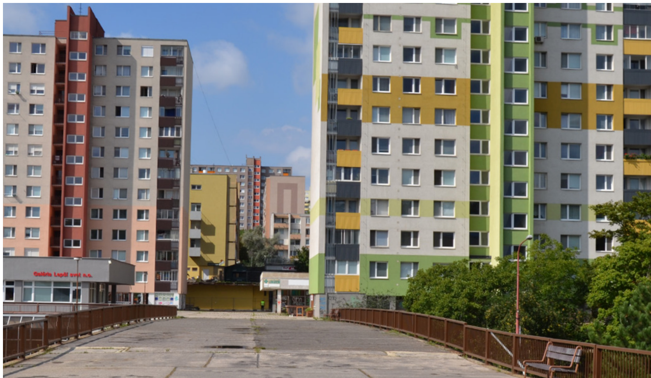
Pešia lávka ponad dopravný koridor
