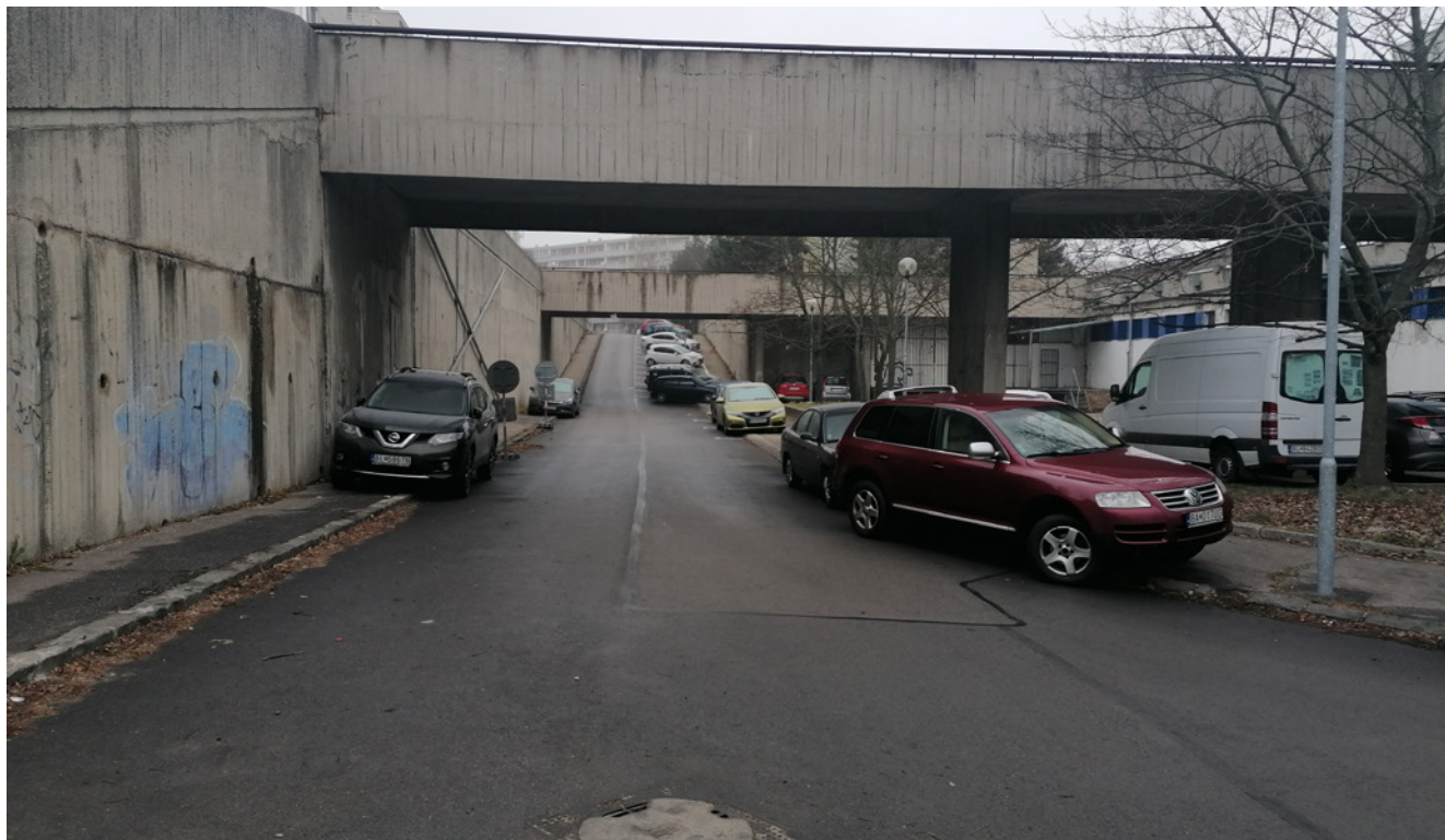
Oporný múr a železobetónové monolitické lávky
