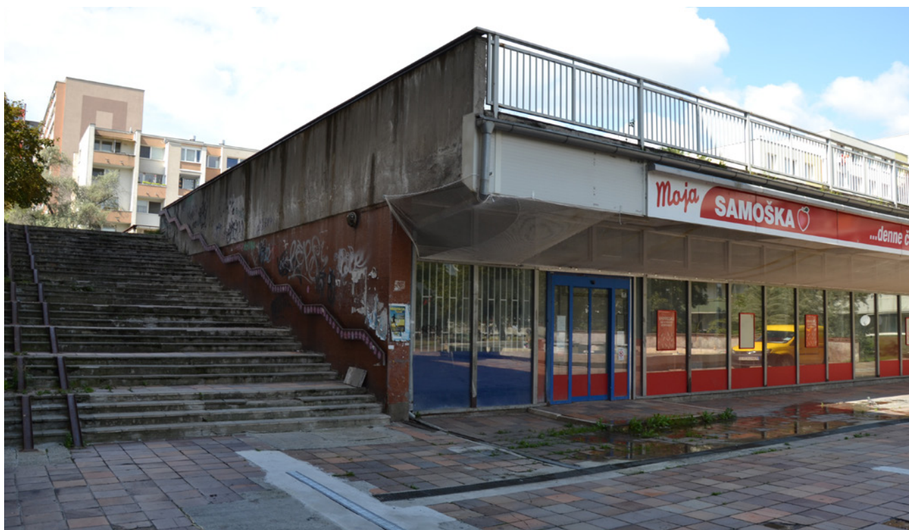
Objekt C1 bývalých potravín - zhotovené z nosnej sústav BAUMS
