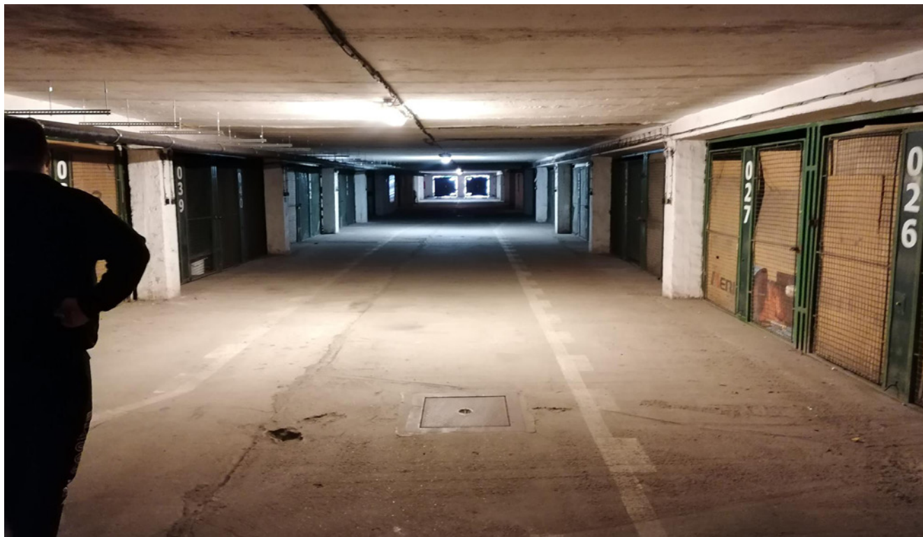
Podzemné priestory garáže Magistrát Foto: MIB
