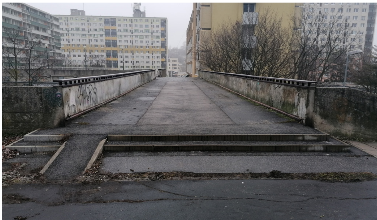
Prepájacia železobetónová lávka s asfaltovým povrchom
