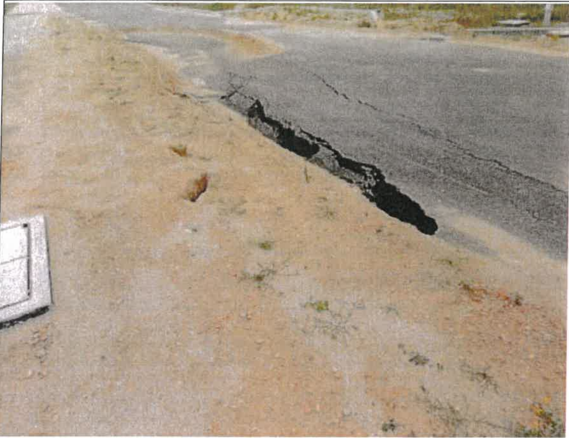
uszkodzenie jezdni
