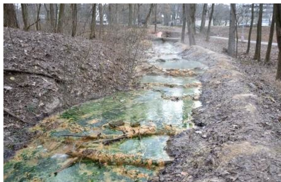
Obrázok 153 Odvodňovací rigol s termálnou vodou ukrytý v poraste drevín
