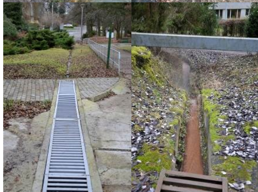
Obrázok 71 - riešenie prekrytých rigolov vody pod chodníkmi k budove Riaditeľstvo (zdroj vlastná fotografia)
