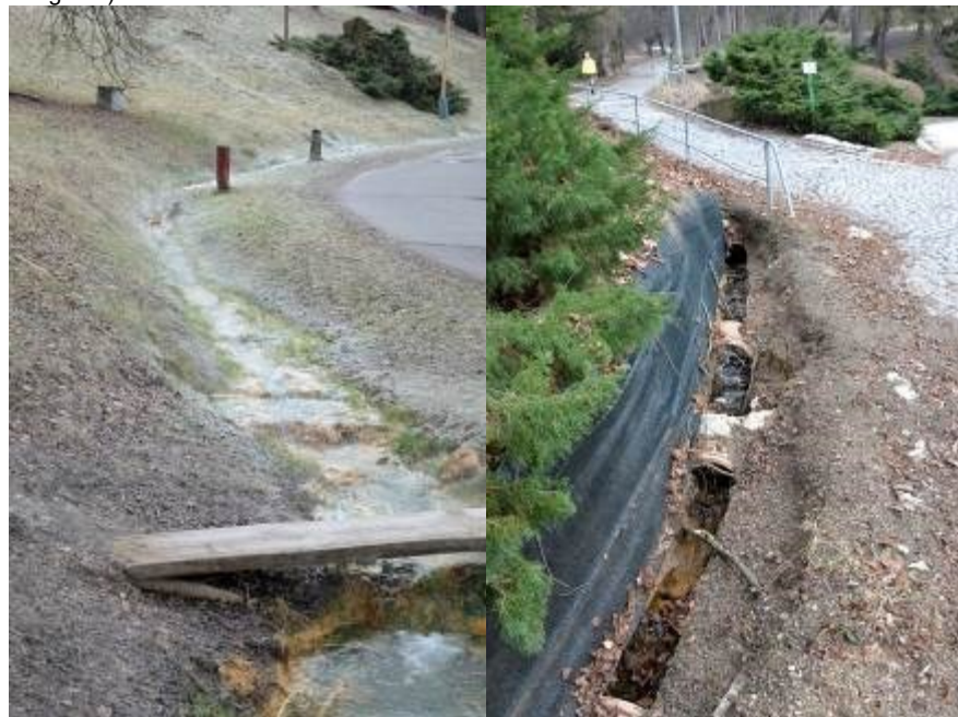
Obrázok 70 - ukážka spôsobov realizácie odvodňovacej siete v centre kúpeľov (zdroj vlastné fotografie)
