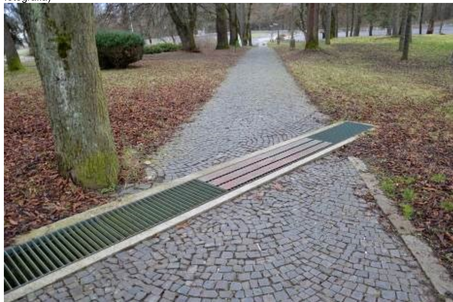
Obrázok 71 - riešenie prekrytých rigolov vody pod chodníkmi k budove Riaditeľstvo (zdroj vlastná fotografia)
