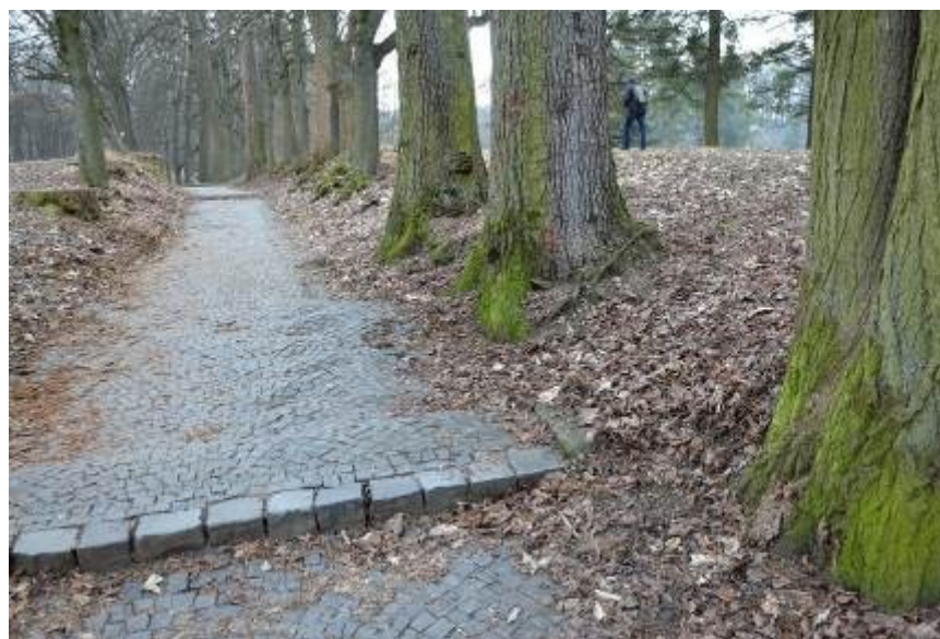
Obrázok 151 Detail na chodníka dláždeného kamennou kockou, ktorý je v niektorých častiach zarezaný do terénu.
