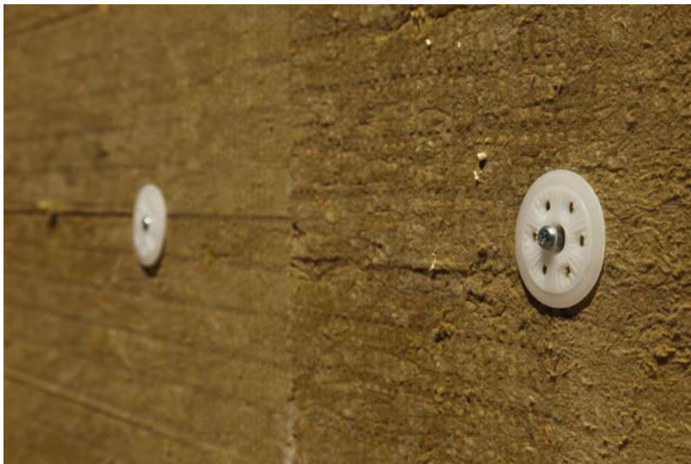
Ukážka vloženia rozpernej kotvy do predvŕtaných otvorov
