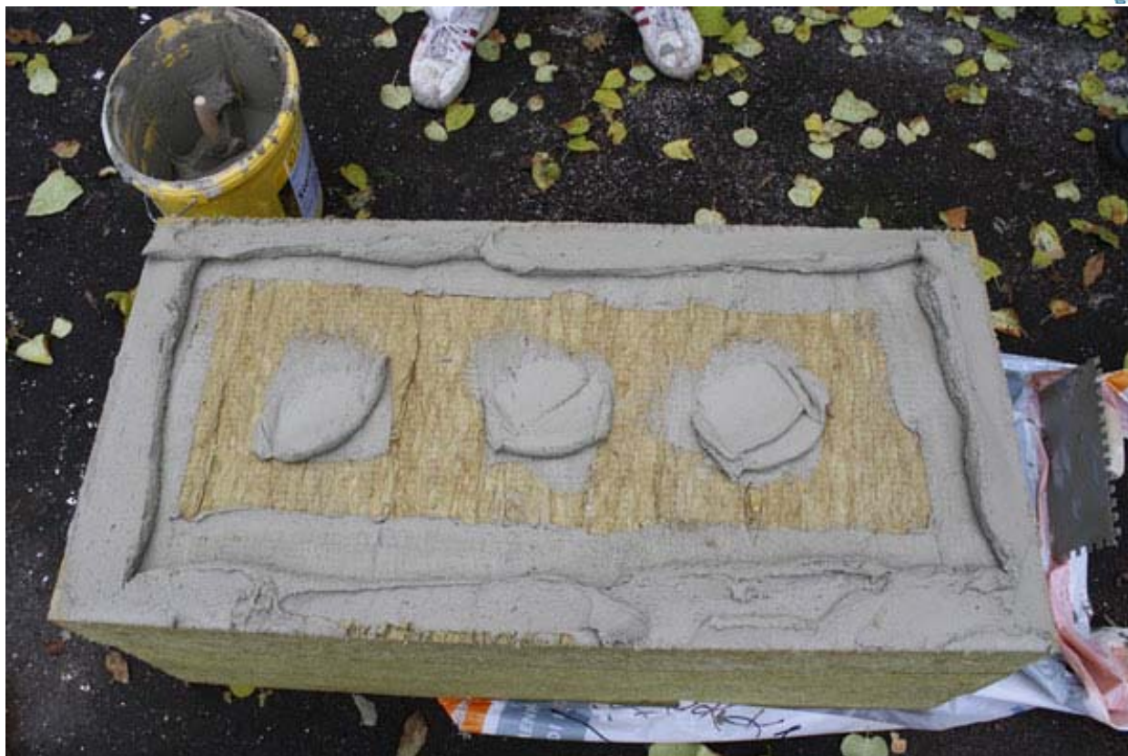
Ukážka správneho nanosenia lepidla na fasádnú dosku
