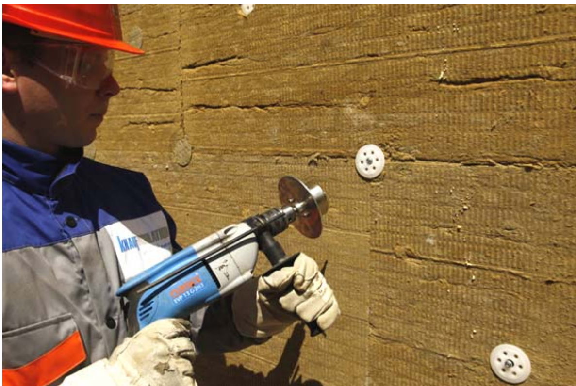
Ukážka prípravku na montáž zapustených rozperných kotiev
