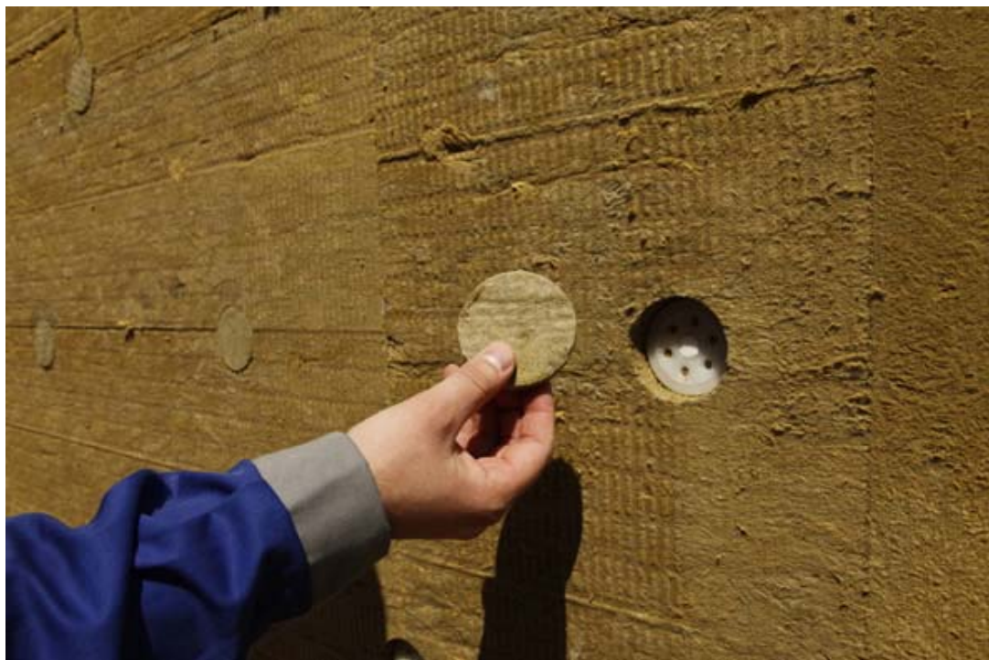
Zátka pre zapustenú montáž rozperných kotiev
