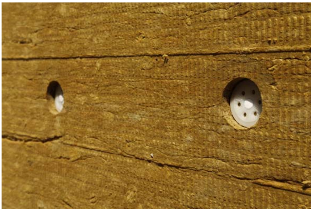
Ukážka montáže zapustenia rozperných kotiev
