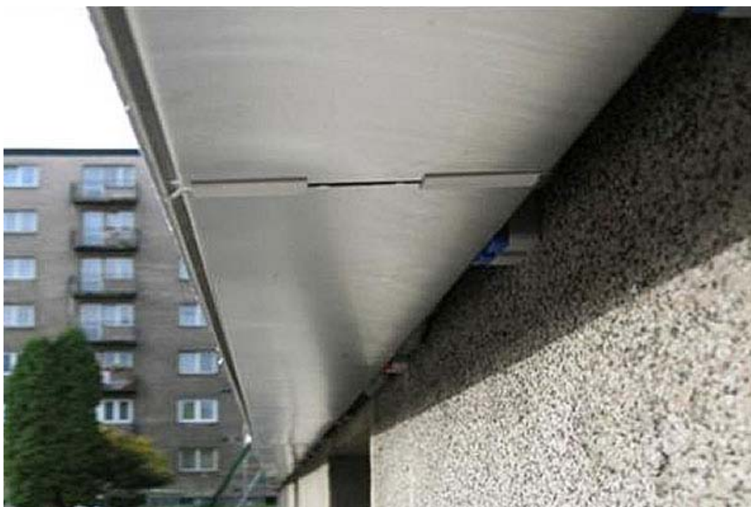
Správne založenie zakladacej lišty
