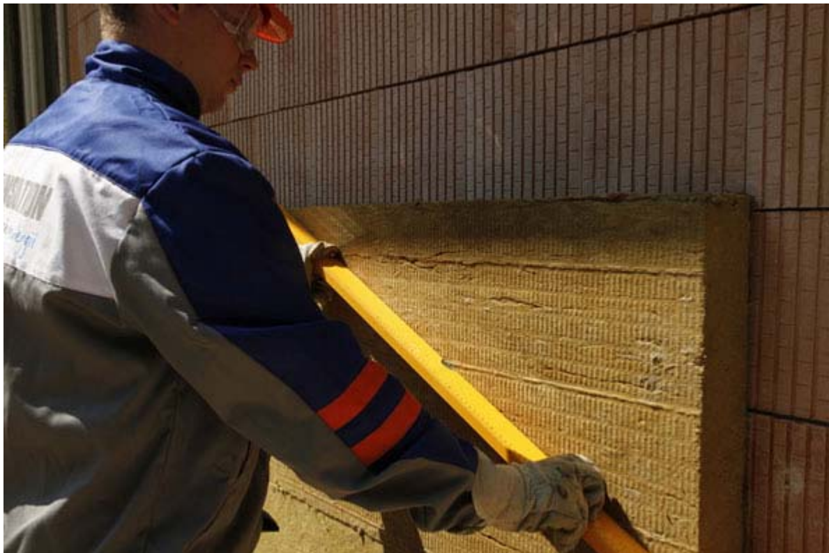
Nivelácia dosky pri lepení na stenu
