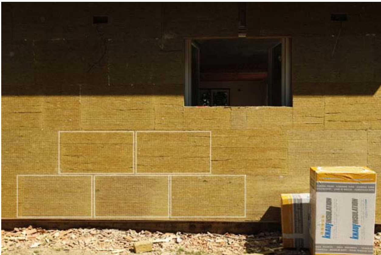
Ukážka správneho uloženia dosiek na stene
