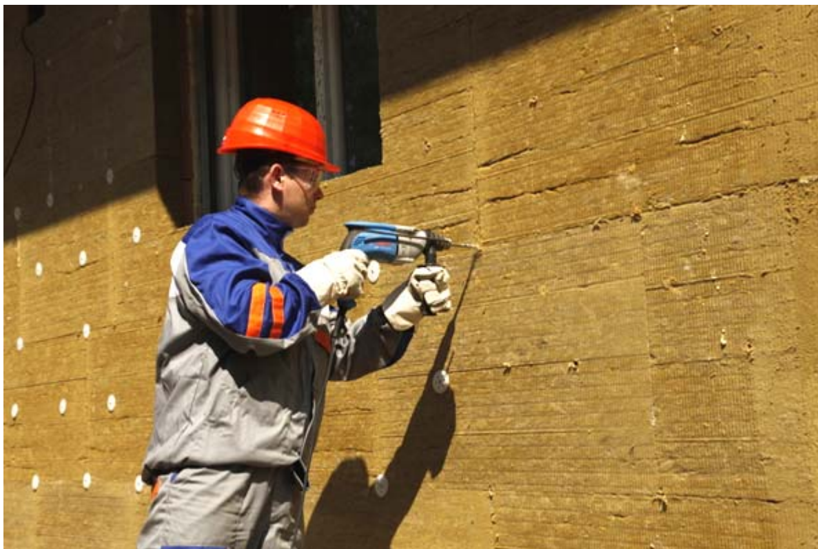
Ukážka vŕtania otvorov - kolmo na stenu
