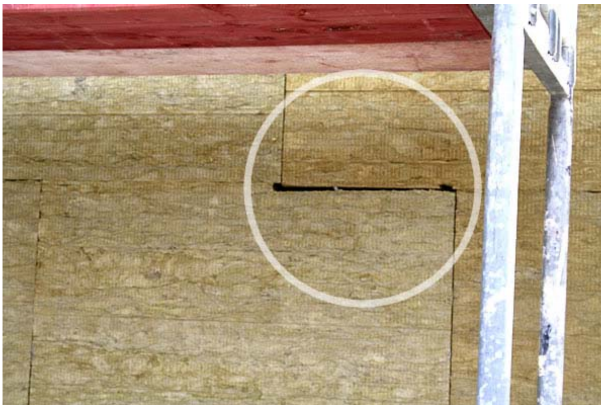
Medzera medzi doskami izolácie - vzniká tepelný most
