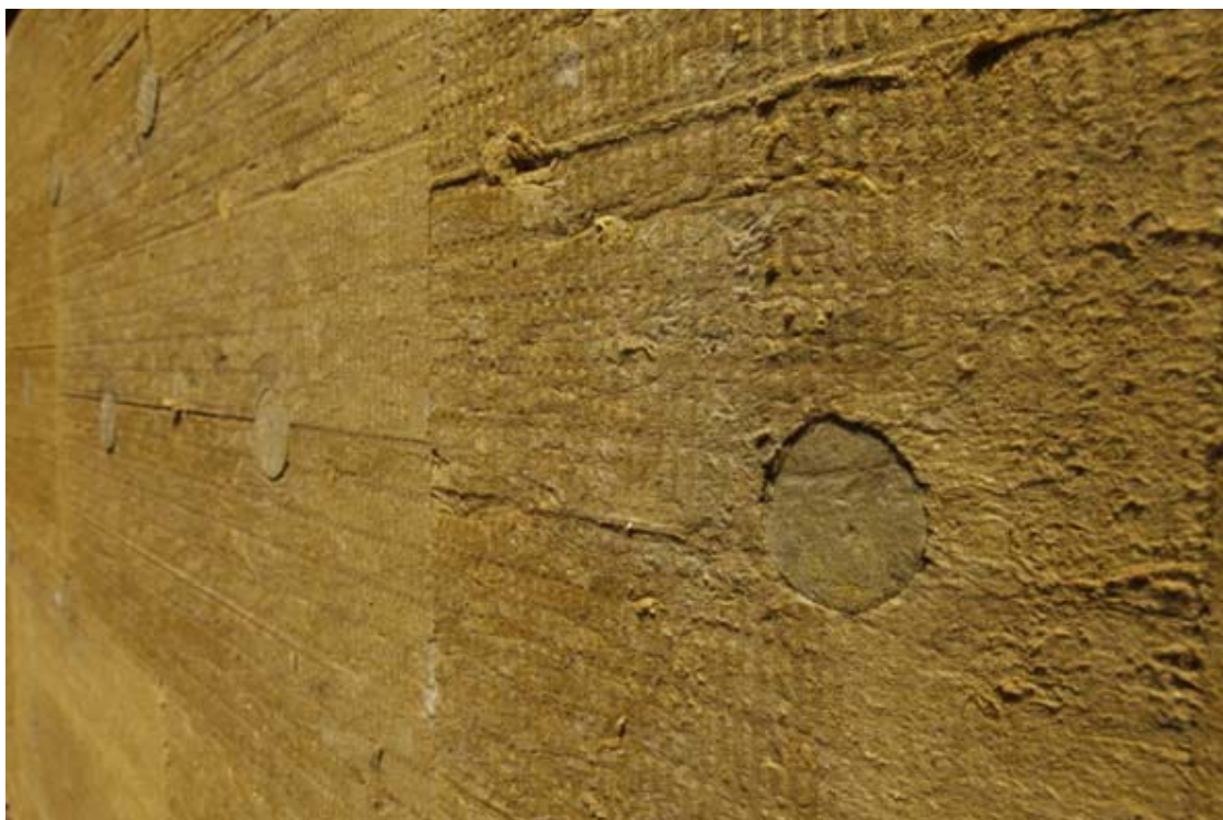
Vložená zátku z minerálnej vlny eliminuje tepelné mosty od rozperných kotiev
