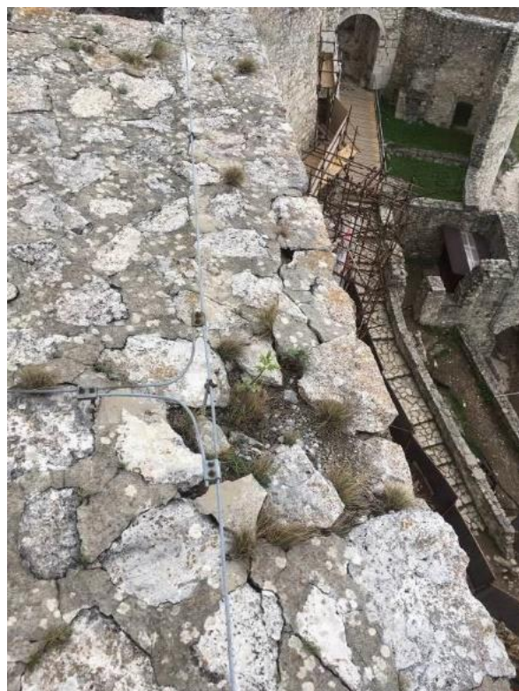
Detail odtrhnutia koruny
