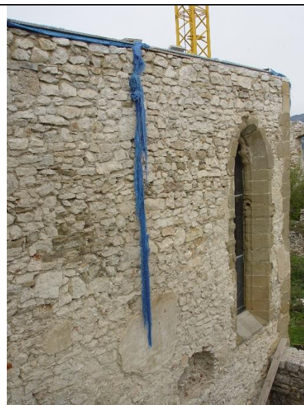
Stav odstránených sekundárnych omietok v arkádovej chodbe západných palácov 09/2022
