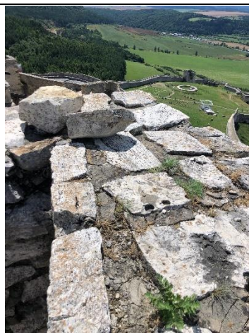
Detail škárovania a ukončenia murív a úprava koruny na kapitánskom dome v 1. etape - vzor pre pokračovanie v 2. etape.
