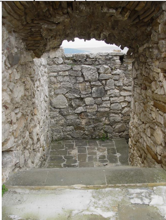
Pohľad na výstupné schodiskové rameno a podestu so záklenkom / nadpražím
