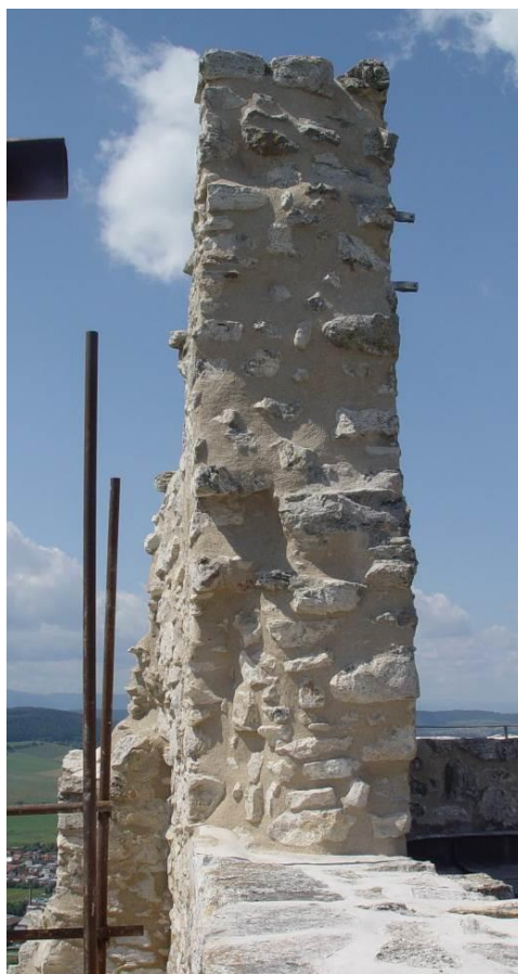
Detail škárovania a ukončenia murív a úprava koruny na kapitánskom dome v 1. etape - vzor pre pokračovanie v 2. etape.
