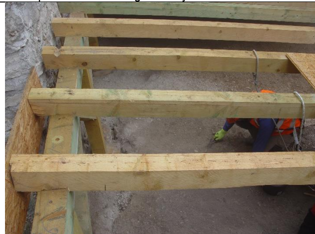
Pod dočasným zastrešením vo vnútri na klenbe 1. NP prebiehajúci archeologický výskum
