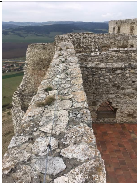
Súčasný stav koruny murív nad terasou – sev. časť.
