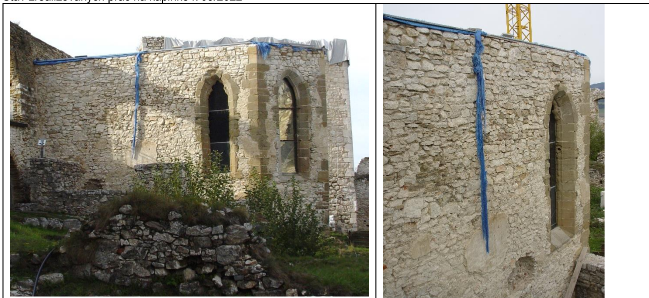
Stav zrealizovaných prác na kaplnke k 09/2022
