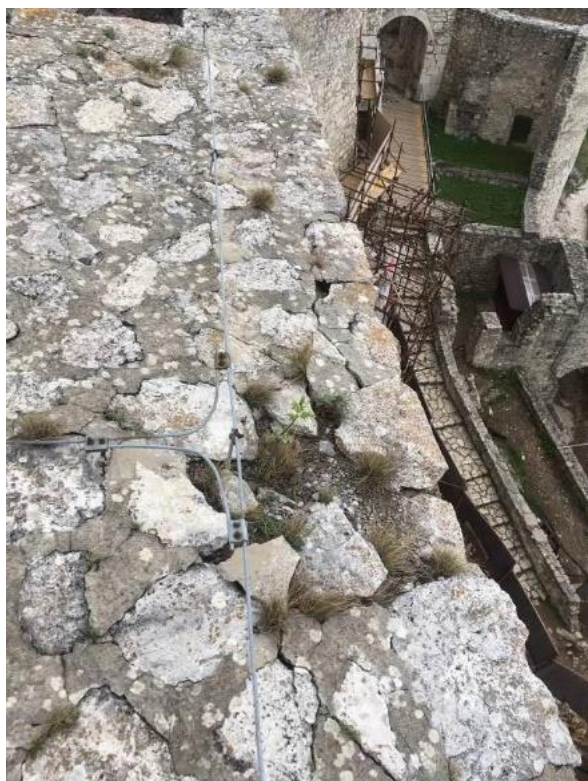
Detail odtrhnutia koruny
