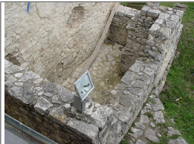
Vyčistený povrch historickej sakristie z južnej strany kaplnky pre odvedenie dažďovej vody atakujúcej murivo kaplnky.
