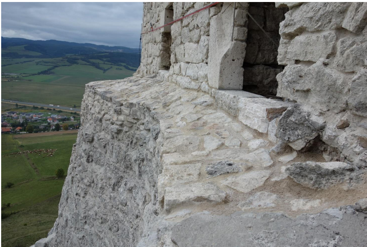
Stav nasadenia muriva paláca na sanovanom skalnom brale, stav 09/2021.
