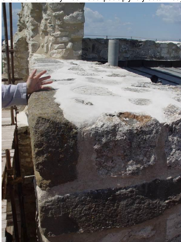
Detail škárovania a ukončenia murív a úprava koruny na kapitánskom dome v 1. etape - vzor pre pokračovanie v 2. etape.
