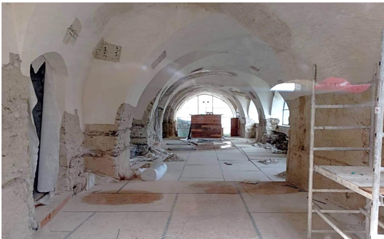
Stav odstránených sekundárnych omietok v arkádovej chodbe západných palácov 09/2022
