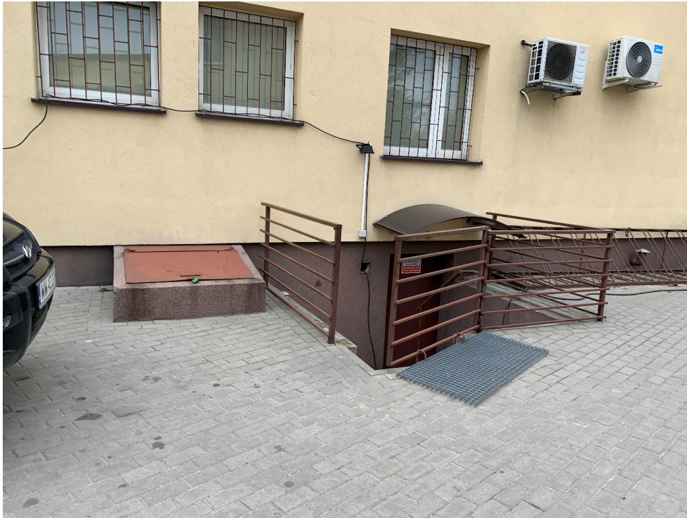
widok na zejście z poziomu terenu do poziomu piwnicy -strona wschodnia
