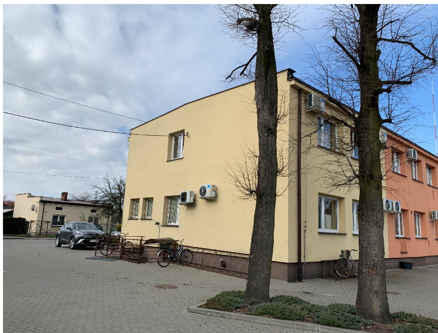
widok na narożnik północno -wschodni .Widoczne zejście do piwnicy do pomieszczeń technicznych
