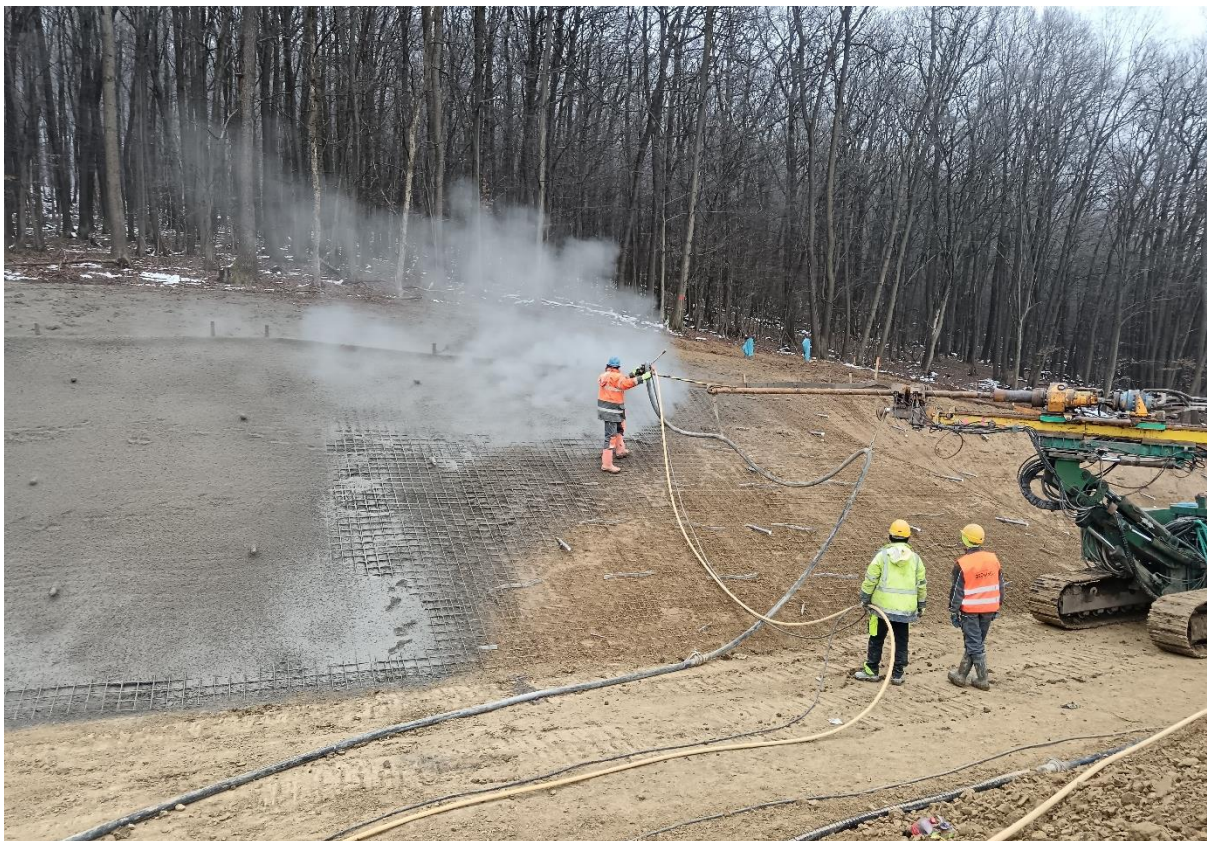
Objekt: 402-00-01-11-01 Striekanie svahu zárezu v sklone 1:1,75 v km 5,0 Dátum: 20.12.2023
