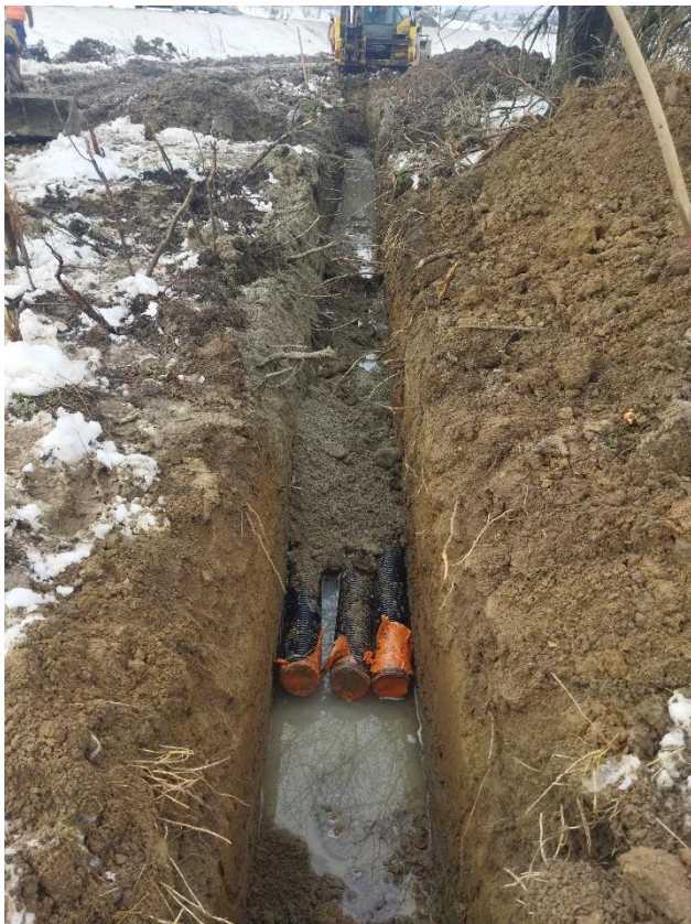
SO 645-00 Položenie chráničiek 3xPVC Ø 150, medzi bodom 4 a 6 Dátum: 12.12.2023
