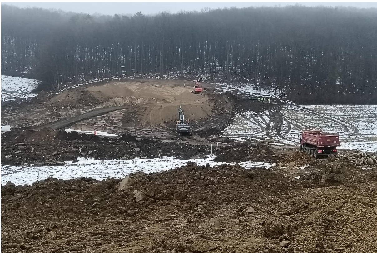
Objekt: SO 402-00-01-11-01 Odkop svahu zárezu v sklone 1:1,75 v km 5,0 (západný portál tunela Okruhliak)
