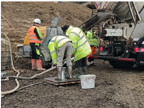
Objekt: SO 402-00-01-11-01 Skúška rozliata betónu, metóda VEBE doska Dátum: 20.10.2023
