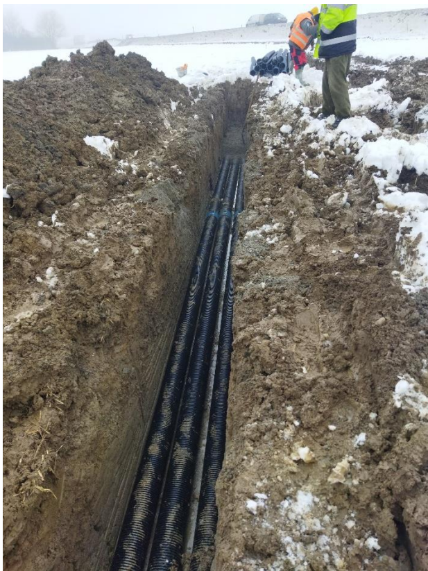
SO 645-00 Položenie chráničiek 3xPVC Ø 150, medzi bodom 8 a 9 Dátum: 13.12.2023
