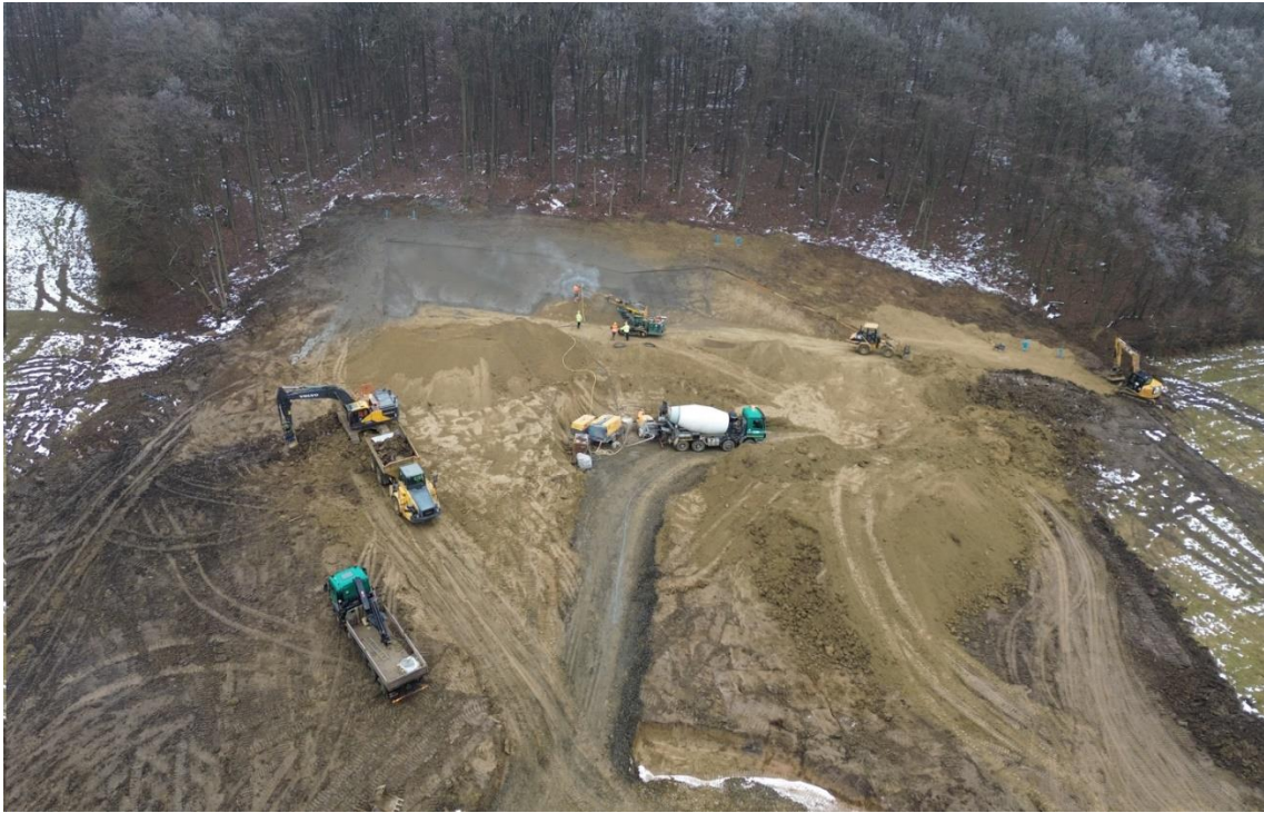
SO 402-00-011 Pohľad na západný portál tunela Okruhliak – zaistovanie nulte úrovne stavebnej jamy v sklone 1:1,75 – aplikácia striekaného betónu. Odťažba hornín odkopaných zo stavebnej jamy.
