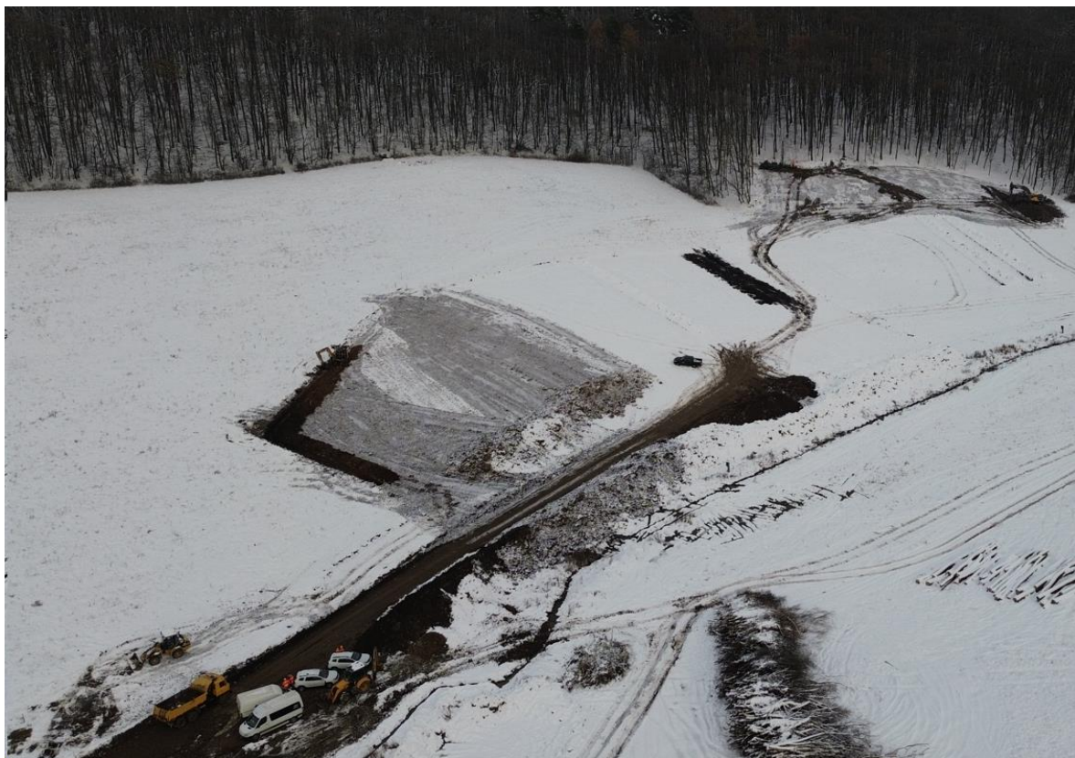
Všeobecné položky - výkop odvodňovacej priekopy okolo ZS
