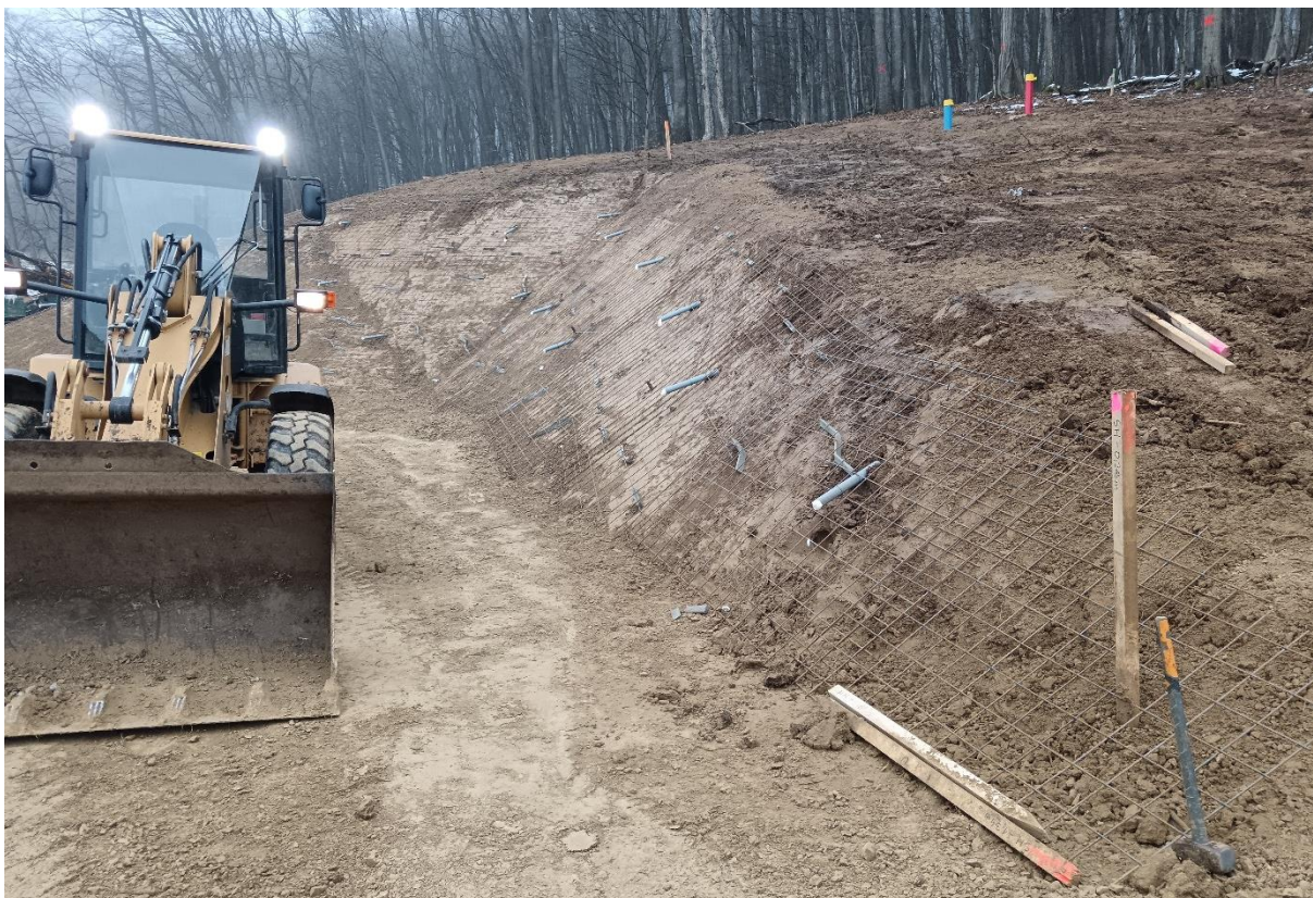
Objekt: 402-00-01-11-01 Spevnenie svahu KARI sieť v km 5,0 (západný portál tunela Okruhliak)
