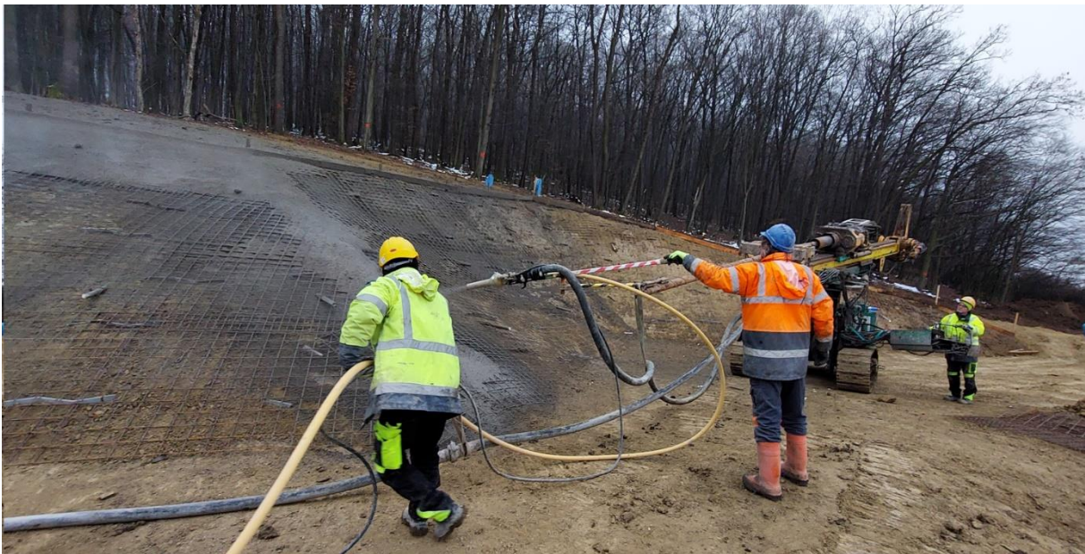
SO 402-00-011 Pohľad na západný portál tunela Okruhliak - Aplikácia striekaného betónu na svahv sklone 1:1,75
