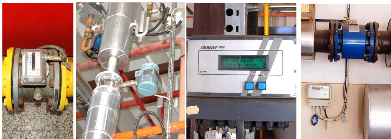
Obr. 11: Meranie množstva spotrebovaného plynu, tepla v pare a vykurovacej vode
