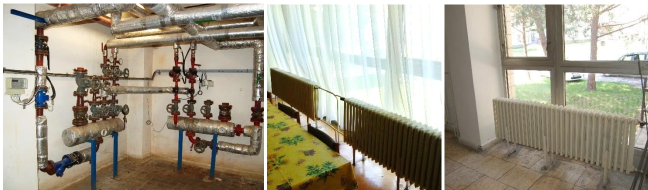
Obr. 49: Vykurovacía sústava
