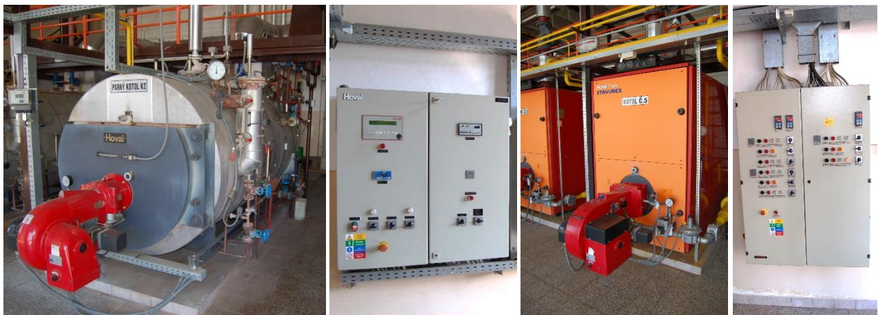
Obr. 10: Kotle a rozvádzač parnej resp. teplovodnej časti
