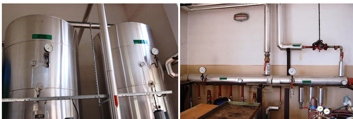
Obr. 17: Vyvedenie TV a C-TV - kotolňa
