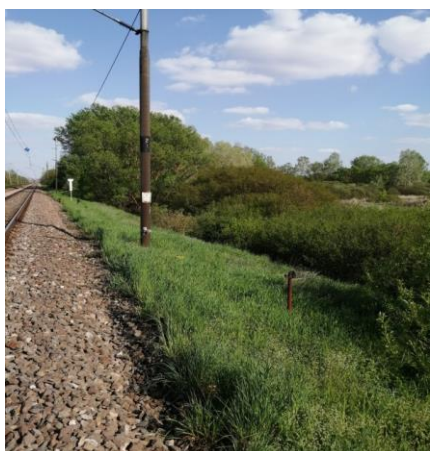
Obr.č.5 Drôtovod na stĺpkoch km 19,040
