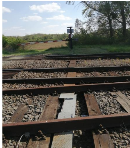
Obr. č. 9 Prechod drôtovodu pod koľajami v km 28,193
