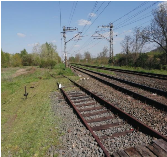
Obr.č.8 Pokračovanie drôtovodu k mechanickému návěstidlu
