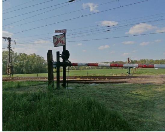
Obr.č.8 Závorový stojan A km 28,536
