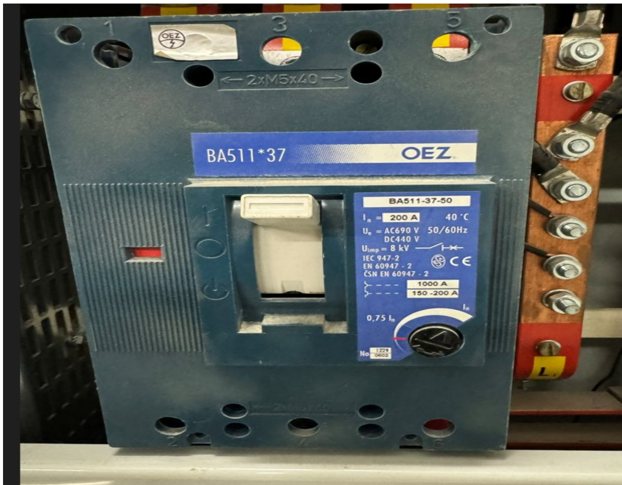
Fotografia č. 2 Istič v Hlavnom objekte
