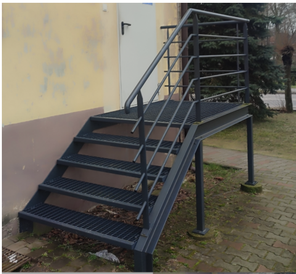
Fotografia 6 Schody od strony zachodniej przeznaczone do demontażu i ponownego montażu
