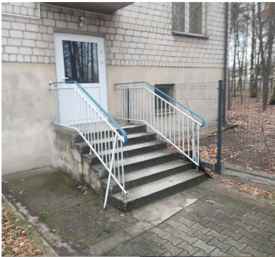
Fotografia 8 Schody od strony wschodniej przeznaczone do remontu
