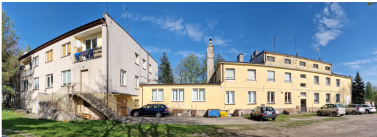
Fotografia 2 Widok istniejącego obiektu - elewacja zachodnia
