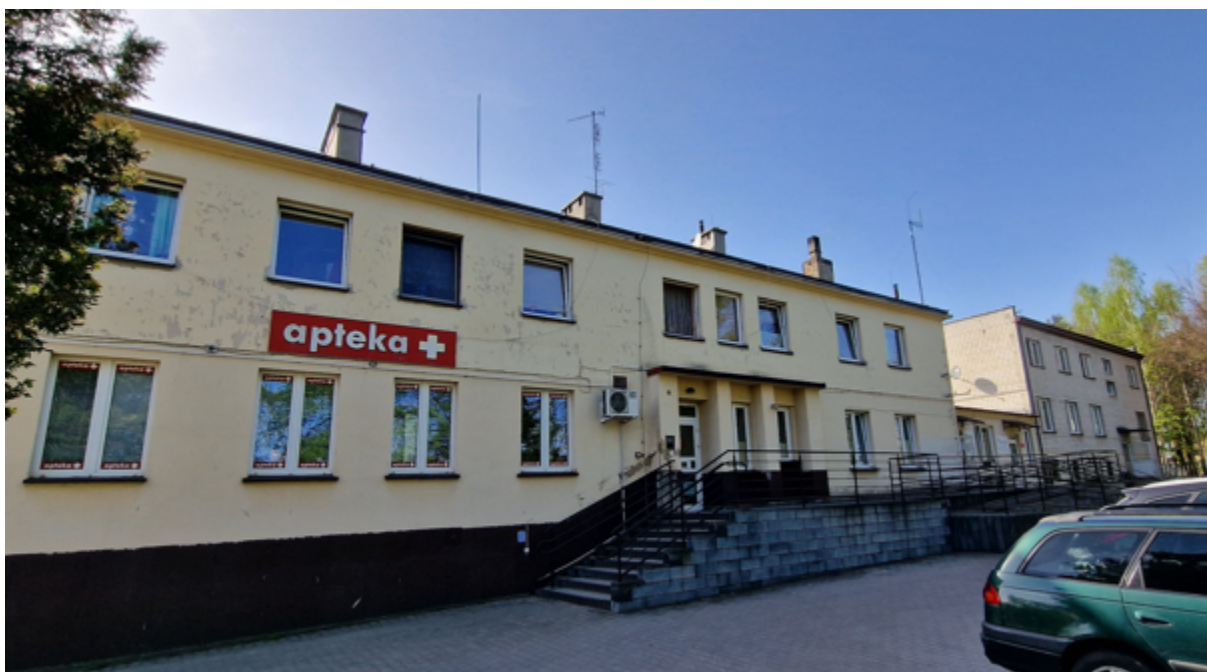
Fotografia 3 Widok istniejącego obiektu - elewacja wschodnia
