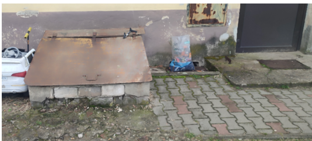
Fotografia 13 Zsypy do piwnic od strony zachodniej przeznaczony do rozbiórki oraz spocznik przy klatce schodowej części mieszkalne.
