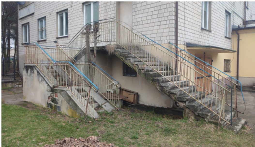
Fotografia 7 Schody od strony zachodniej przeznaczone do rozbiórki
