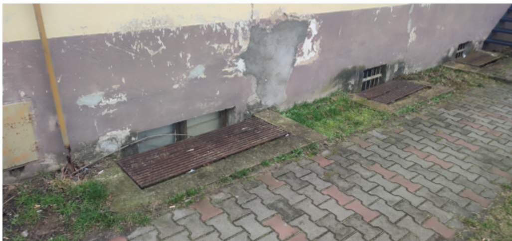
Fotografia 11 Widok części studzienek okiennych od strony zachodniej przeznaczonych do likwidacji
