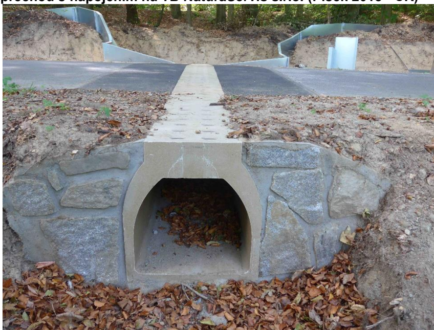
Polymerbetonový přechod s napojením na TB NaturaServis s.r.o. (Písek 2018 - ČR)
