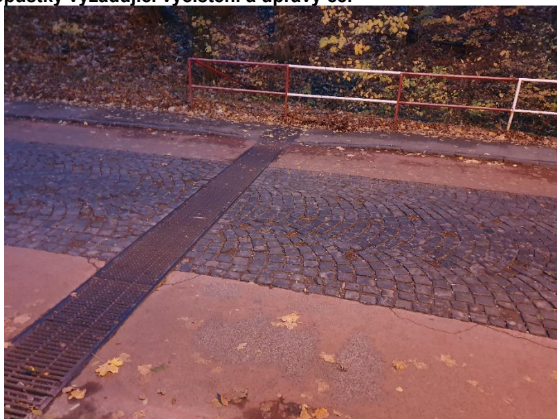
Stávající kovové propustky vyžadující vyčištění a úpravy čel
