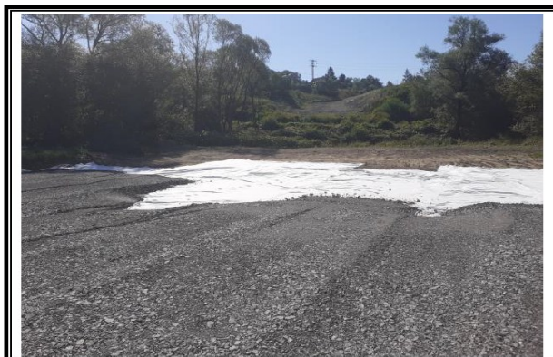
Pokládka geotextílie
