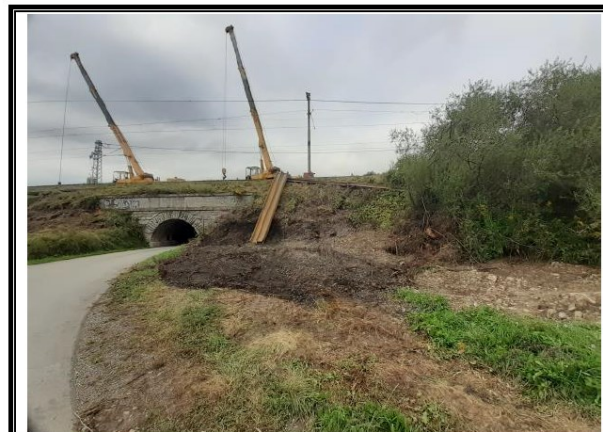
Realizácia pažiacej štetovnicovej steny
