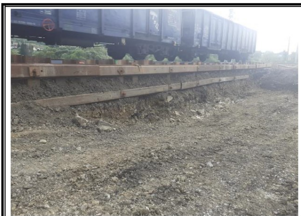
Realizácia pažiacej štetovnicovej steny
