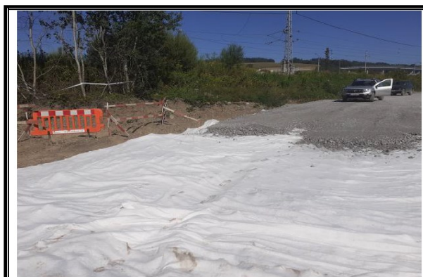
Pokládka geotextílie
