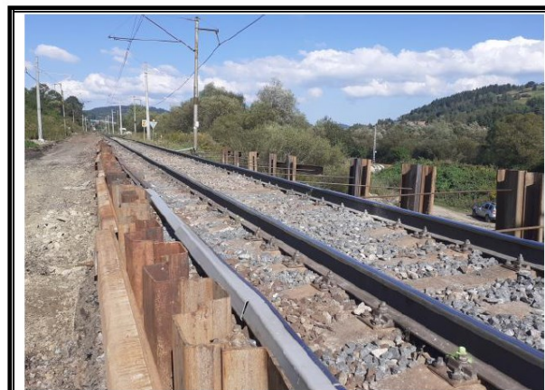
Realizácia pažiacej štetovnicovej steny
