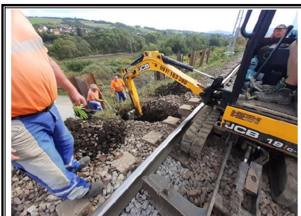
Realizácia pažiacej štetovnicovej steny
