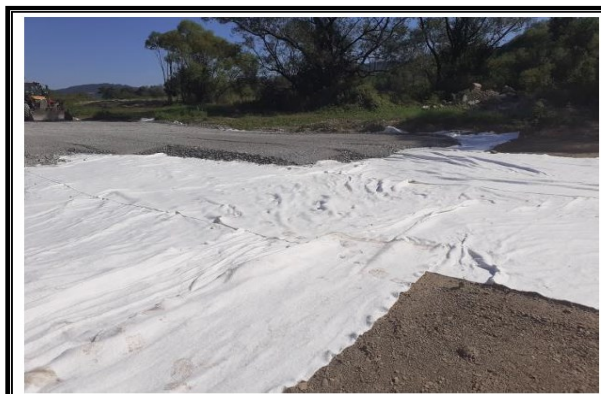
Pokládka geotextílie
