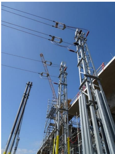
99-35-05 TNS Žilina, pripojenie napájacieho vedenia na trakčné vedenie
