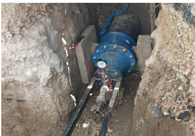
53-37-02 Žilina Strážov - Váh, preložky vodovodov (vľavo) 53-37-03.5 Ochrana odľahčovacej stoky DN 1200 v sžkm 201,600 (vpravo)
