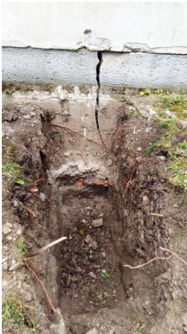
Kopaná sonda so základovým pásom so základovou škárou ešte v navážkach
