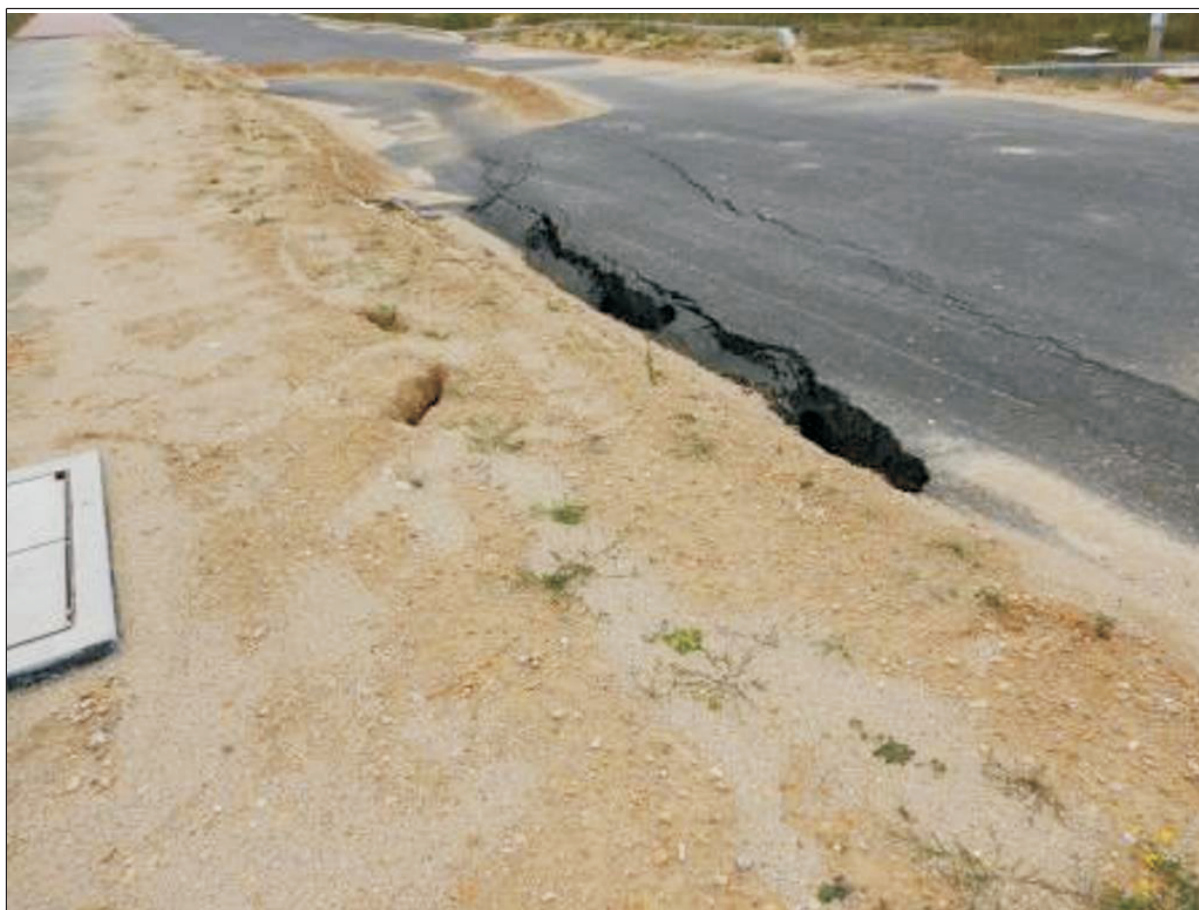
uszkodzenie jezdni
