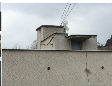
Murovaný priestor na streche OÚ
