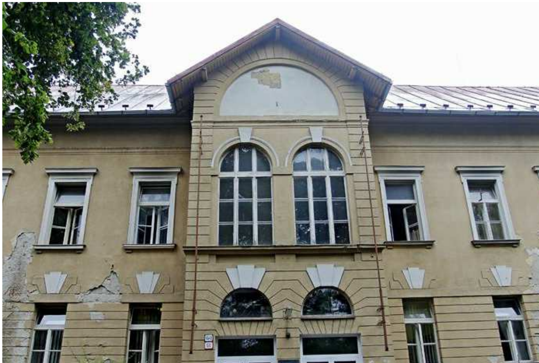
Pôvodný stav - detail južnej fasády
