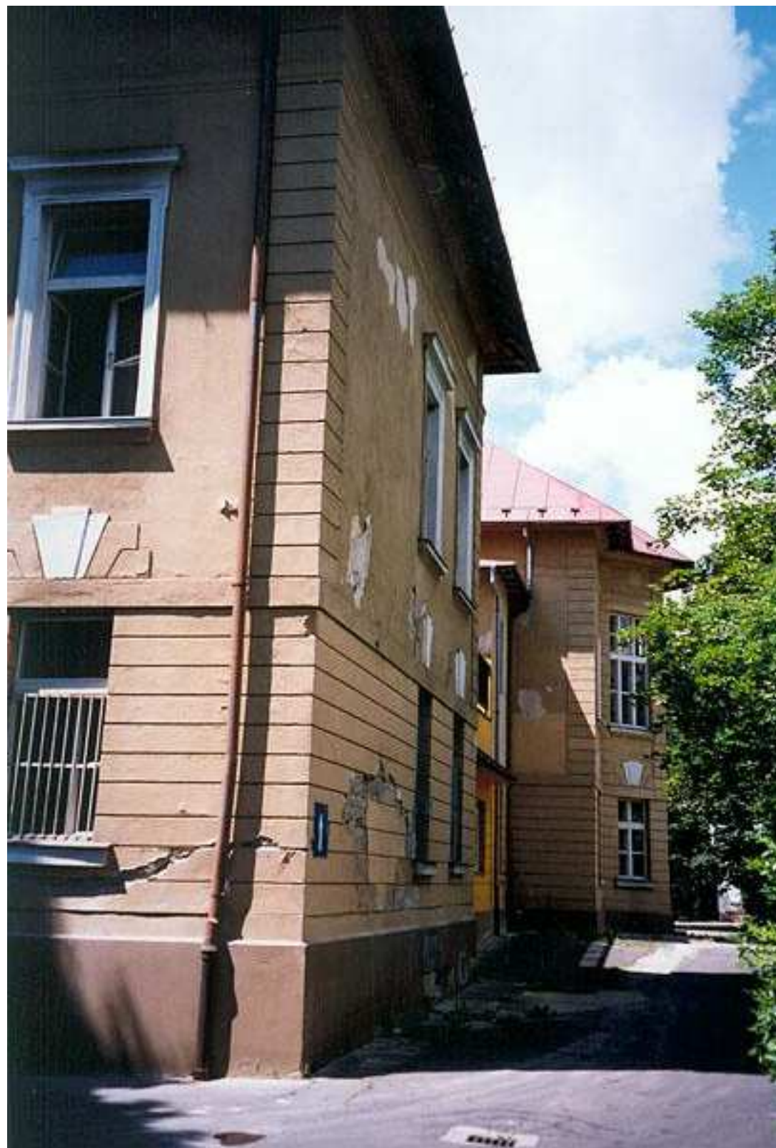
pôvodný stav - pohľad na nárožie so severnou a východnou časťou fasády
