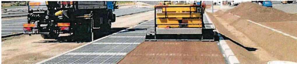
Obrázok 4 Vmetávanie výplňového substrátu do medzier
