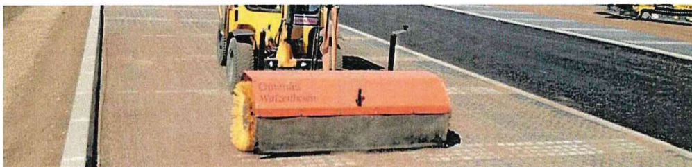
Obrázok 4 Vmetávanie výplňového substrátu do medzier
