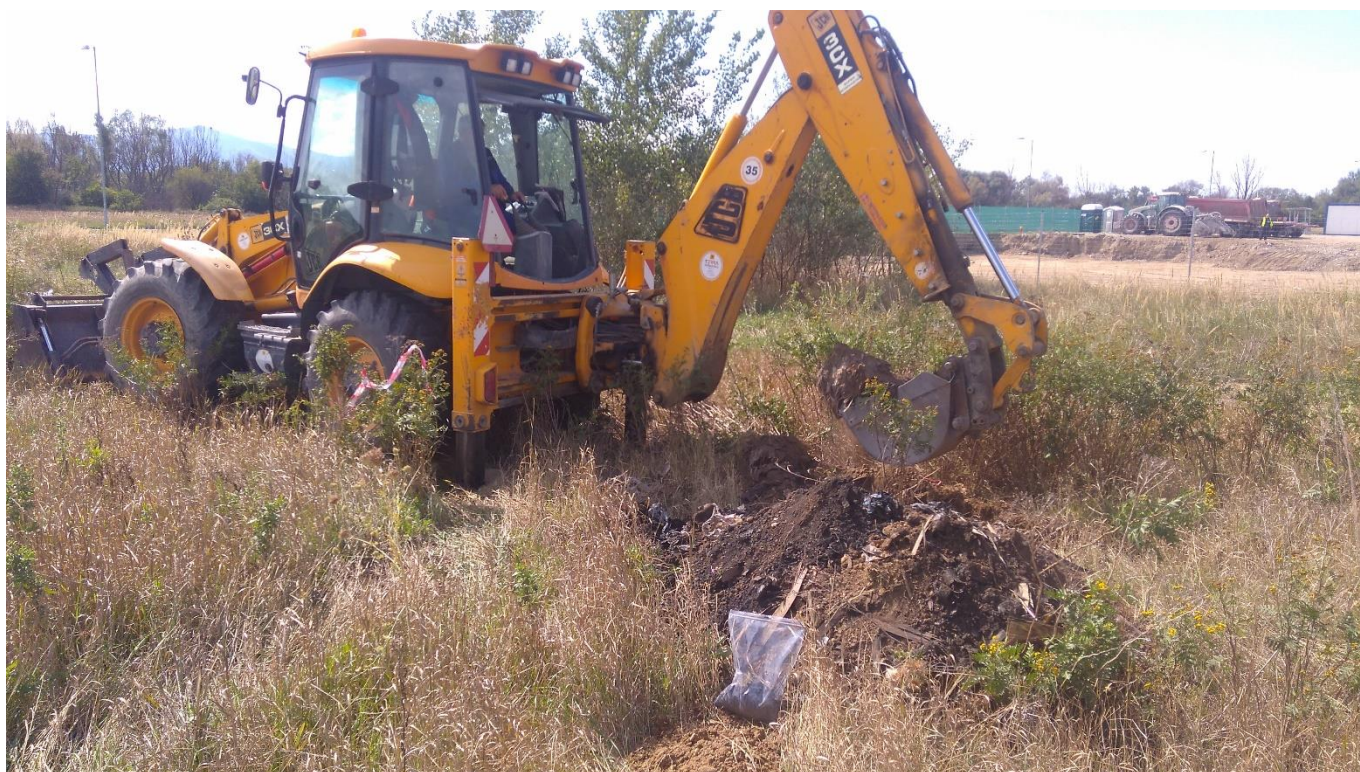
01 Realizácia výkopov na lokalite
