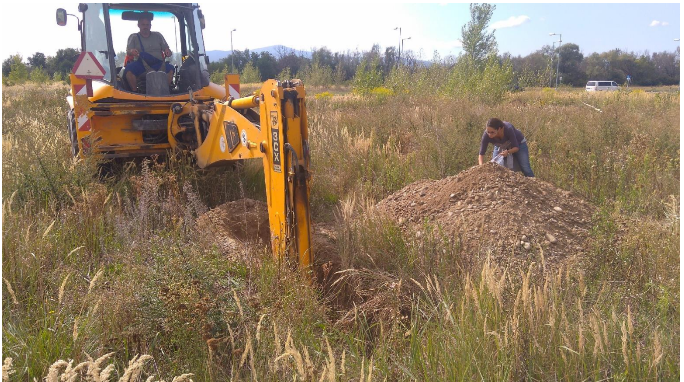
04 Odoberanie vzoriek z jednotlivých výkopov
