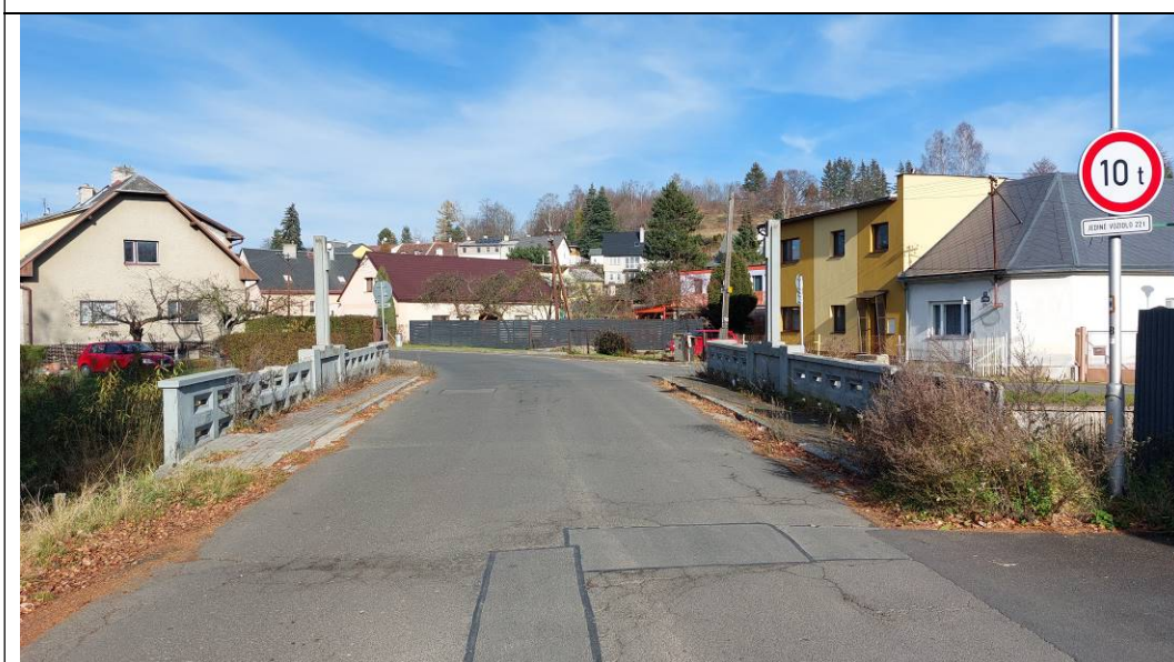
Pohled proti směru staničení (na ulici U Potoka)
