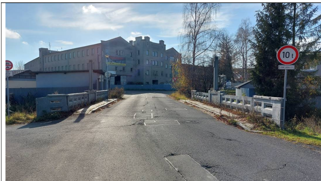
Pohled ve směru staničení (z ulice U Potoka)
