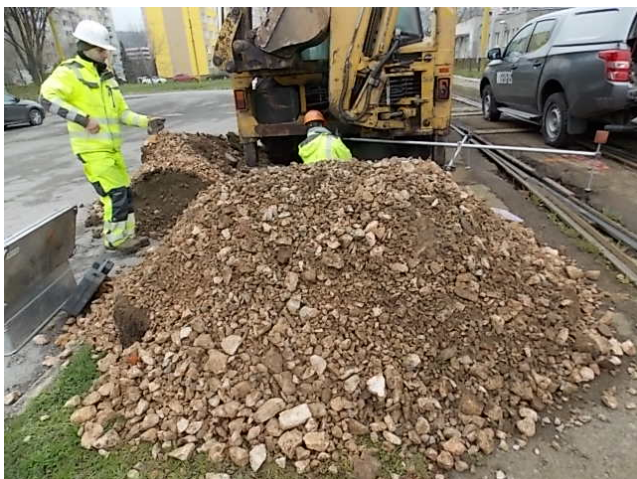
Obrázok 3 Kamenitá drť s prímiesou piesku a siltu z kopanej sondy SZS18-02
