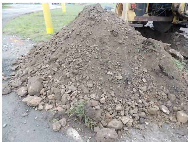
Obrázok 2 Premiešaný výkopový materiál s úlomkami až balvanmi
