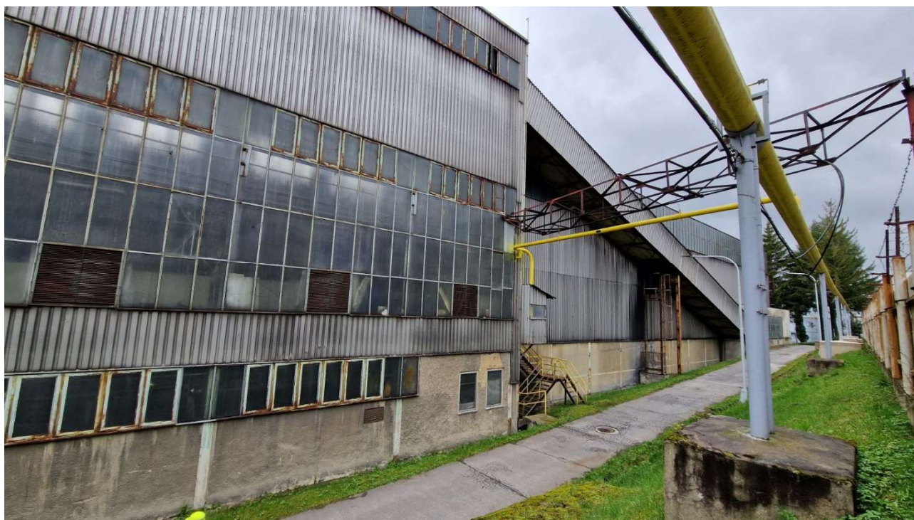
Obr. Kotelna – pohled ze severu, návaznost na uhelnu s dopravníkem, nadzemní plynovodní potrubí (odbočka bude odpojena)
