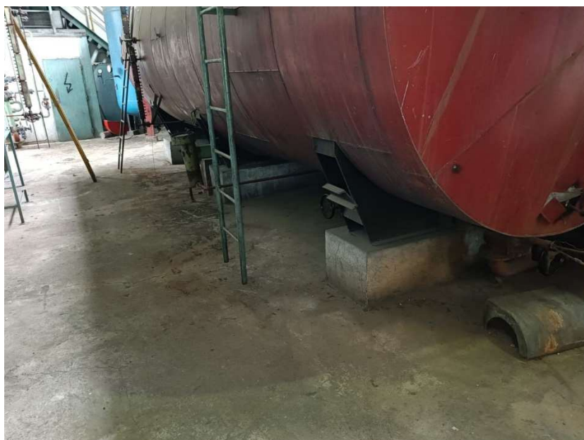
Obr. Kotelna 3.NP – kotvení nádrže k demontáži
