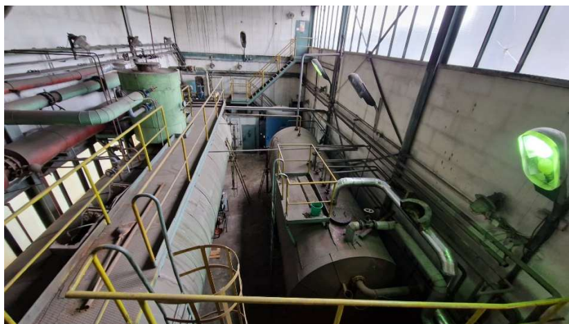
Obr. Kotelna 3.NP – dvě nádrže k demontáži
