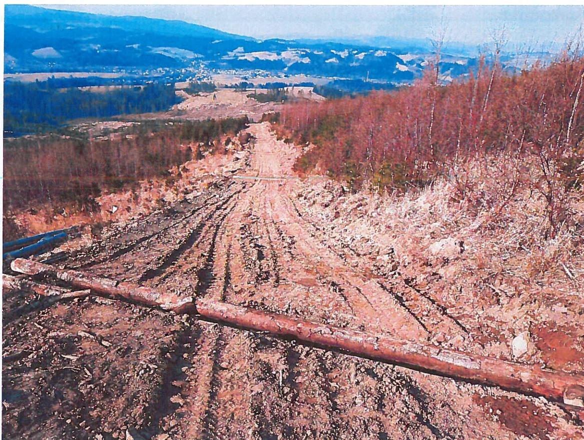
Obr. 2 Ukážka realizovaných drevených odrážok na zväžnici.
