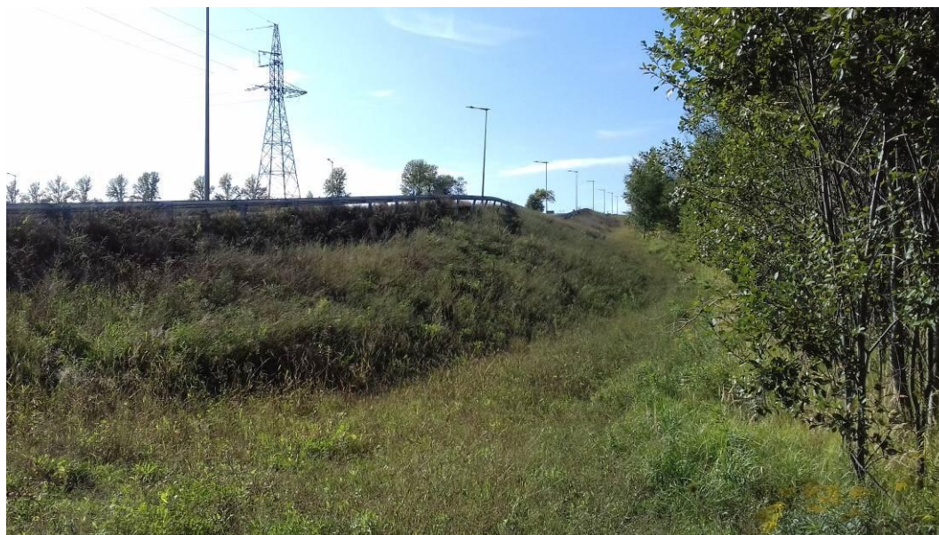
Fotogram nr 38- osunięta skarpa ulicy Strefowej, w miejscu najbardziej wysuniętym na wschód gdzie nasyp był najwyższy.
