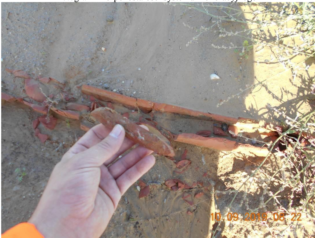
Fotogram nr 6 pozostałości systemu melioracyjnego, materiał ceramiczny
