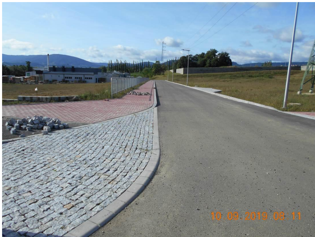
Fotogram nr 40- krawężnik nad murem oporowym 3, brak deformacji krawężnika
