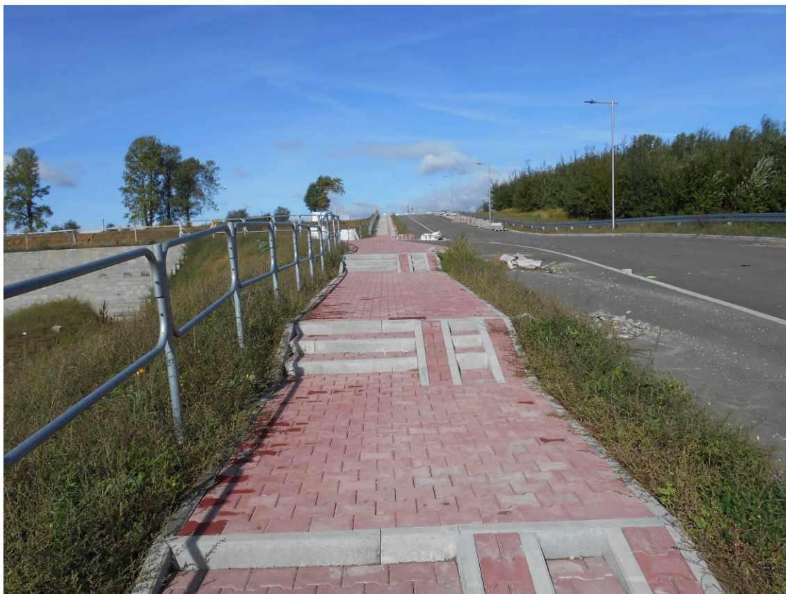
FOTOGRAM 7 – widok chodnika bez możliwości poruszania się osób niepełnosprawnych
