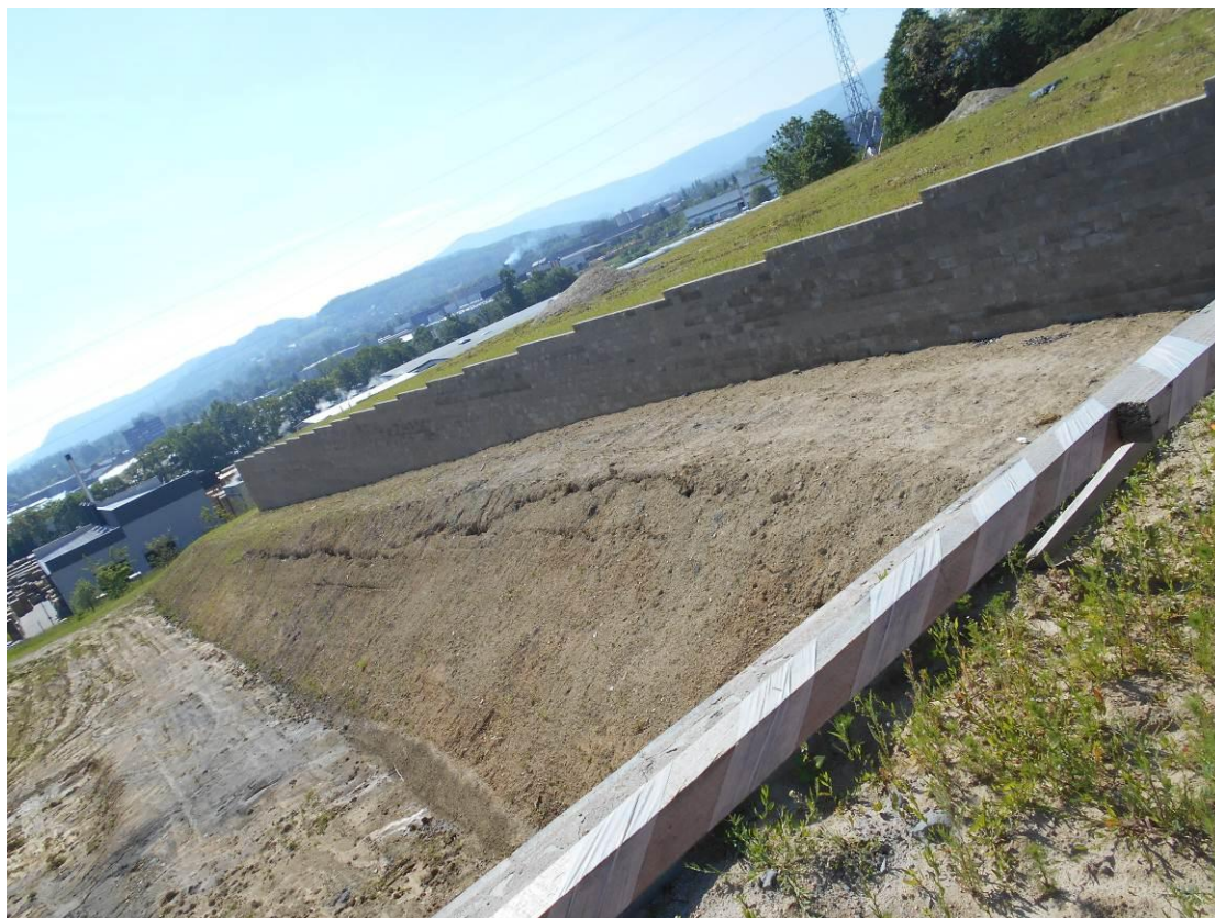
FOTOGRAM 4 – widok murów oporowych zabezpieczonych nasypami gruntowymi
