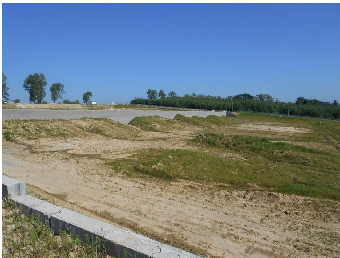
FOTOGRAM 3 – widok murów oporowych zabezpieczonych nasypami gruntowymi
