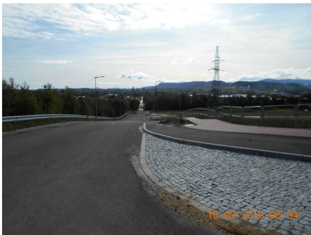
Fotogram nr 34- prosty krawężnik ulicy Strefowej, fragment pomiędzy Białą Drogą, a nowo budowaną ulicą łączącą ul. Strefową z ul. Przemysłową, brak przemieszczeń
