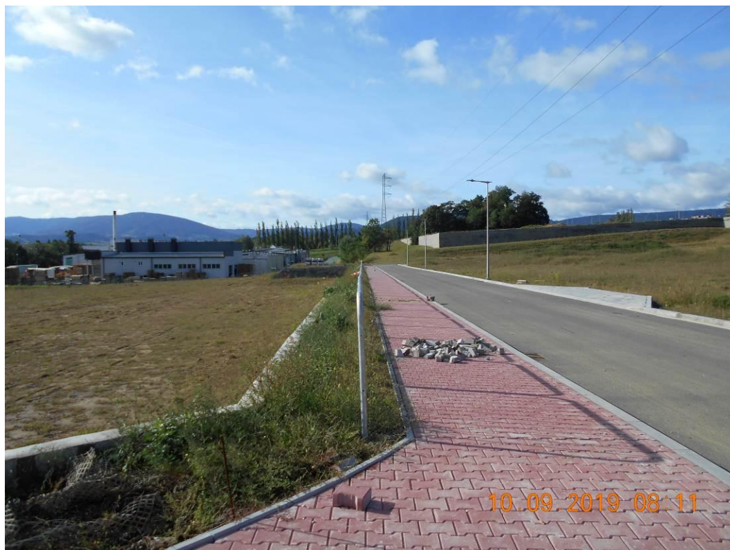
Fotogram nr 41- krawężnik nad murem oporowym 3, brak deformacji balustrady
