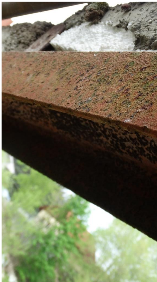
Detail korózie spodného pásu
