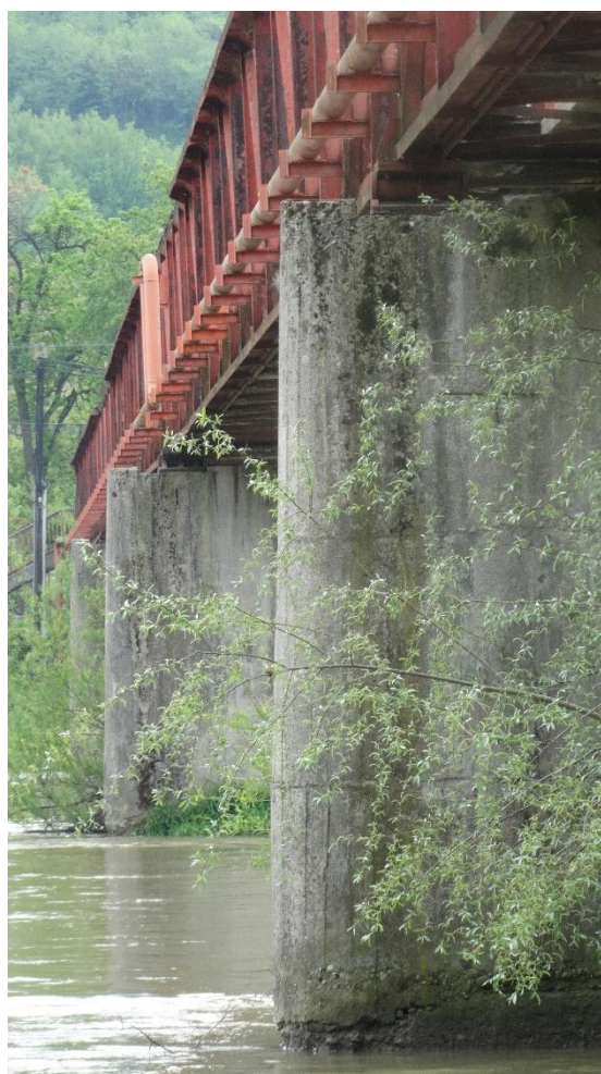
Poškodenie pilierov
