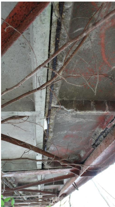
Poškodenie prefabrikovaných dielcov mostovky
