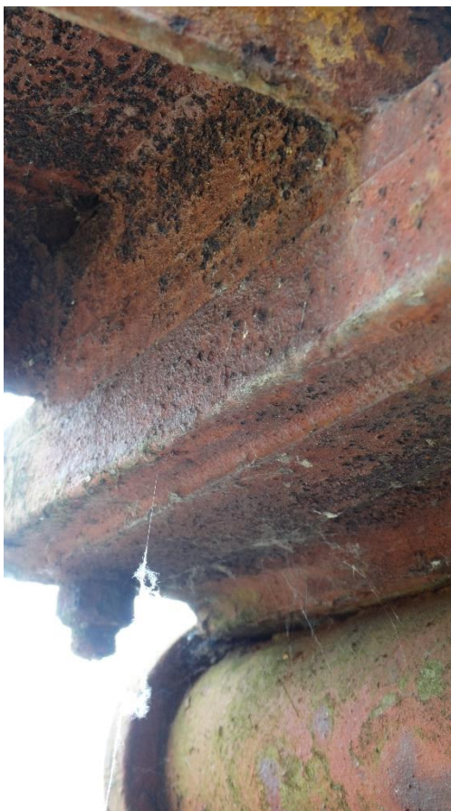
Detail uloženia ložiska
