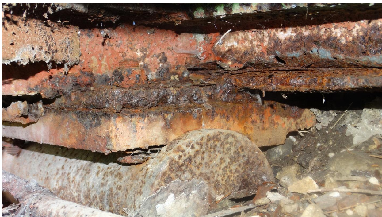
Korózia ložiska a priečnika
