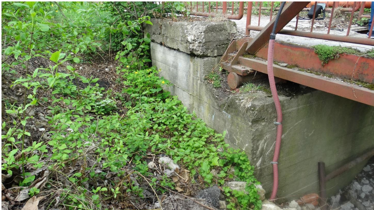
Poškodenie uloženia ložiska
