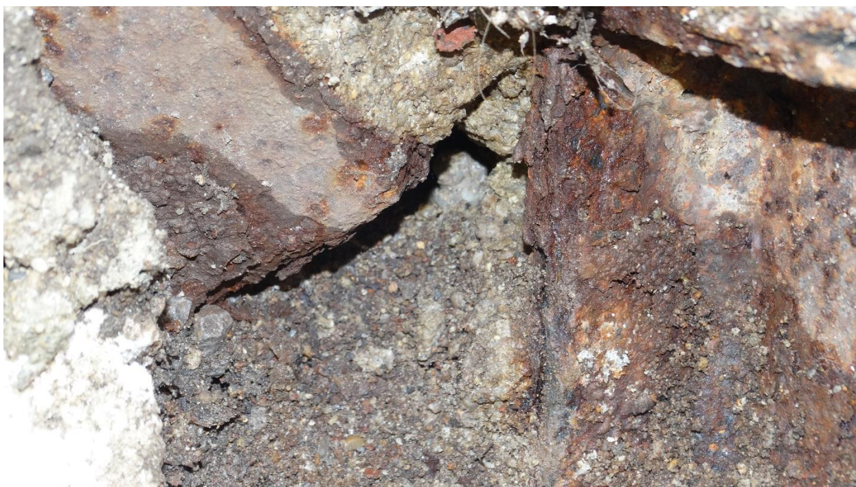
Detail prípoja diagonál – značná korózia styčníkov
