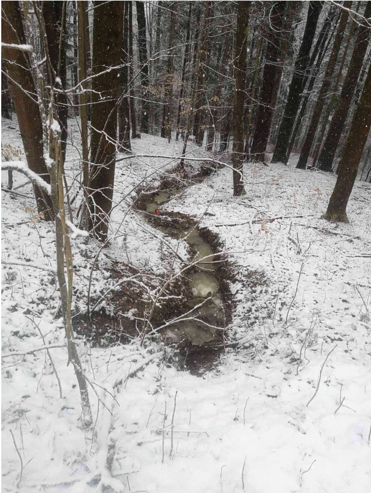
Priepust + cestná priekopa + vodný tok, bystrina – číslo 17
