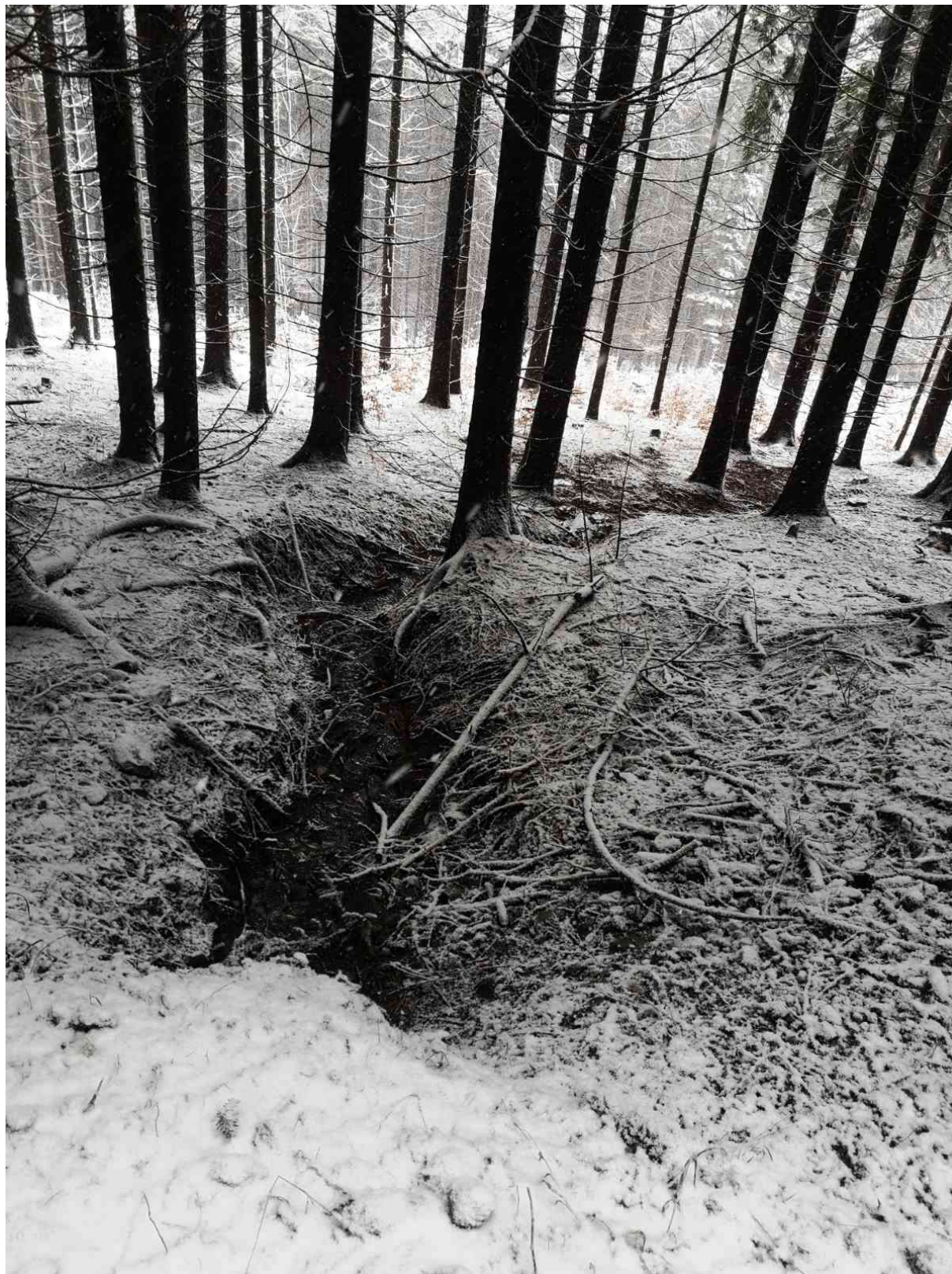
Priepust + cestná priekopa + vodný tok, bystrina – číslo 16
