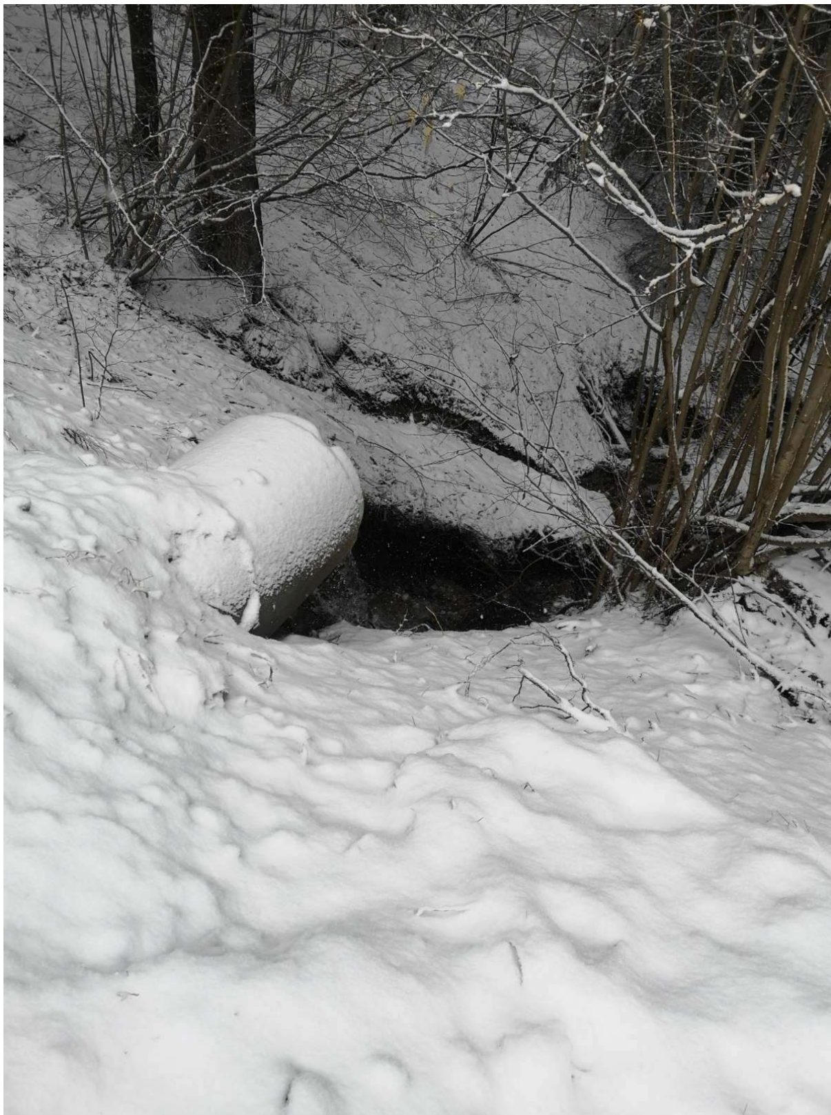
Priepust + cestná priekopa + vodný tok, bystrina – číslo 12
