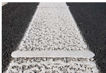
Obrázok 6: Štruktúrne VDZ s priečnym profilovaním pre vodiace čiary
