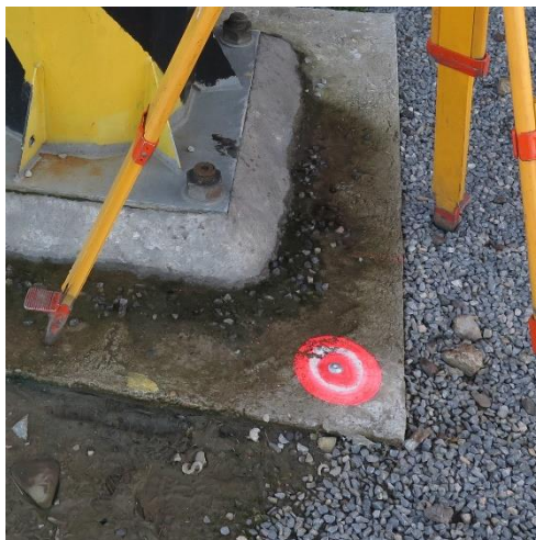
Obr. č. 3. Meračský kliniec v betónovom základe
