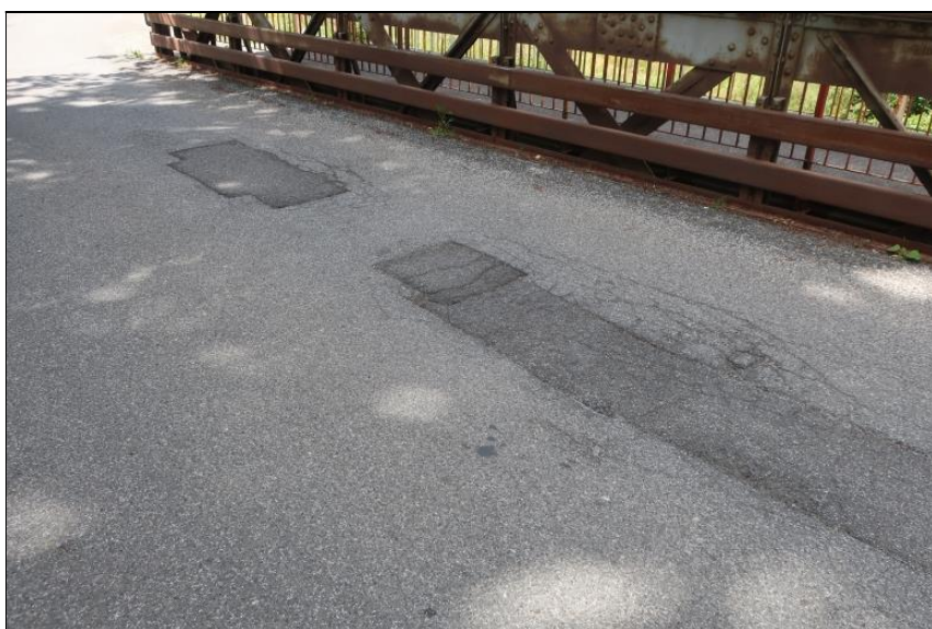
opravy a poruchy krytu vozovky
