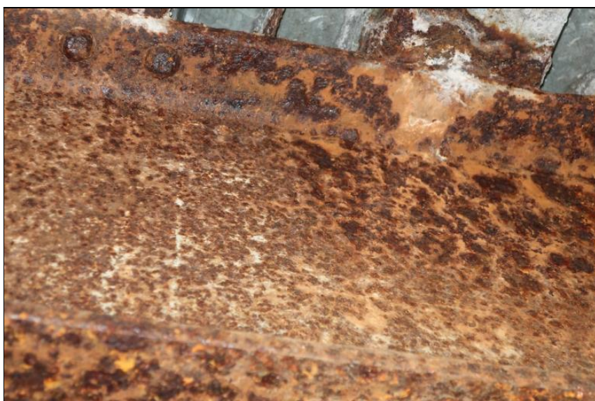
významná koroze příčníku v místě průsaku z mostovky
