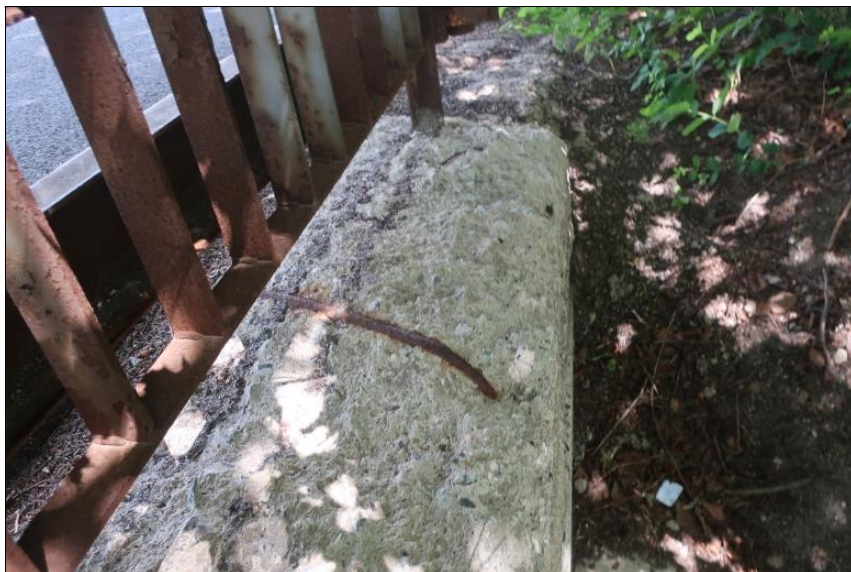
degradace betonu pravé římsy za mostem
