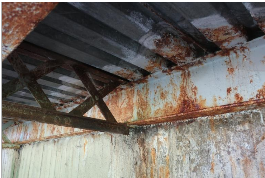
stopy po průsacích na lici ZZ O1 koroze ztraceného bednění mostovky u O1
