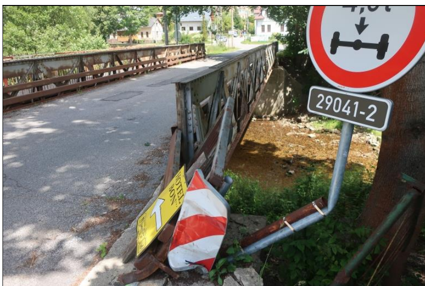
deformovaný záchytný systém vpravo před mostem
