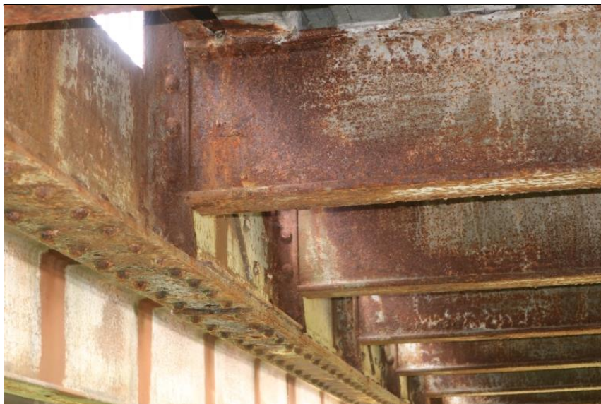
korodující styčníky příčník - spodní pás levého hlavního nosníku
