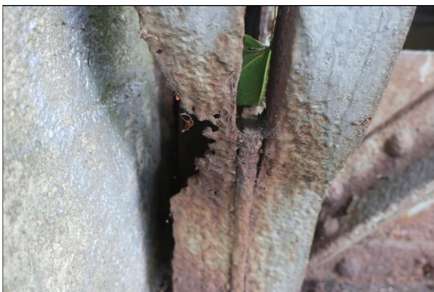
prorézlý ocelový profil na pravé straně NK nad O1
