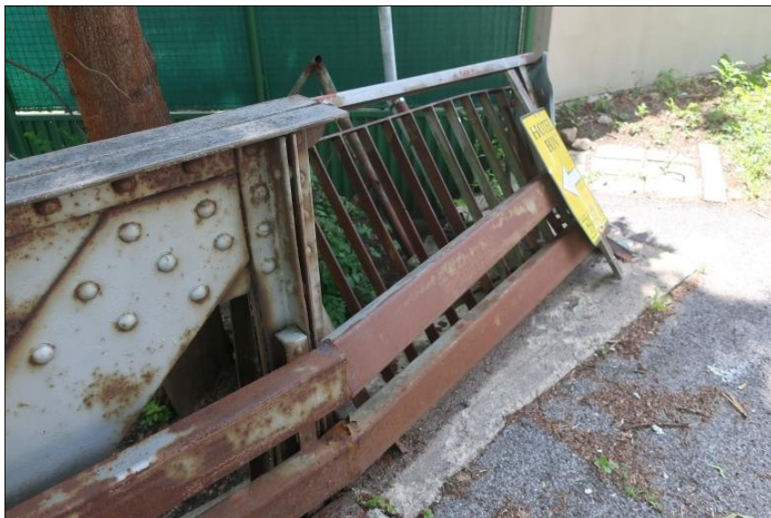
deformovaný záchytný systém vpravo před mostem
