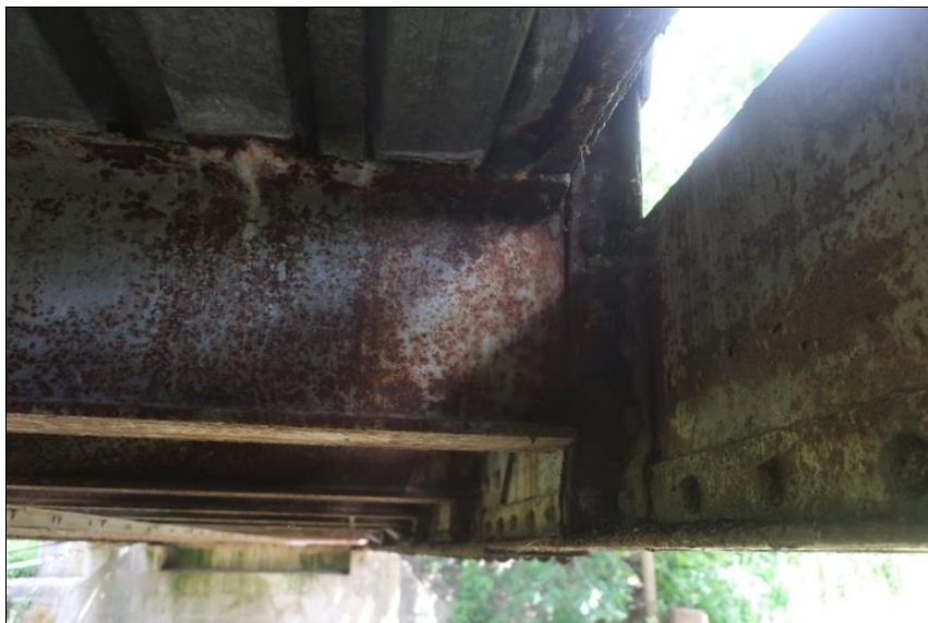
koroze příčníku
