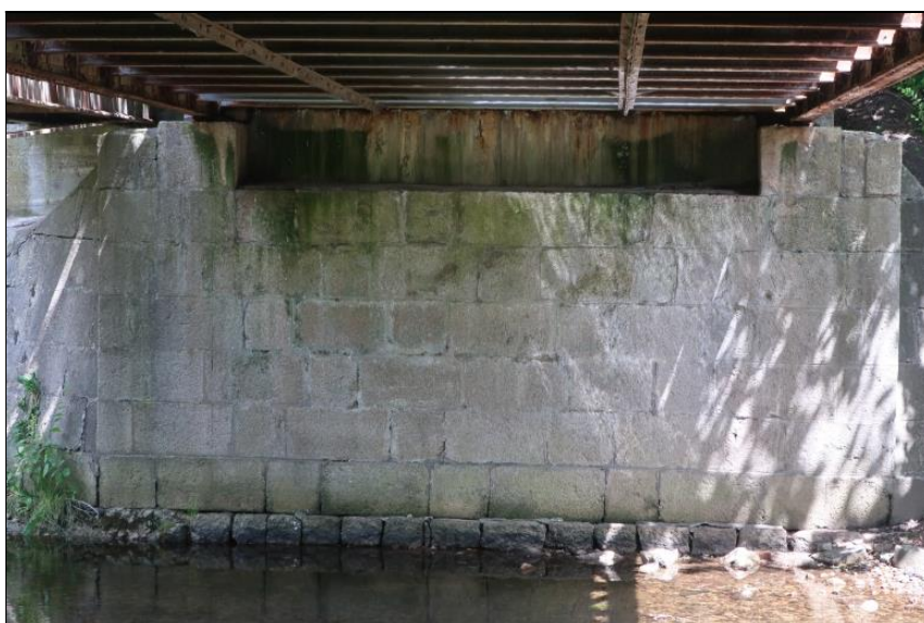
O2 poruchy spárování v úrovni kolísání hladiny Kamenice
