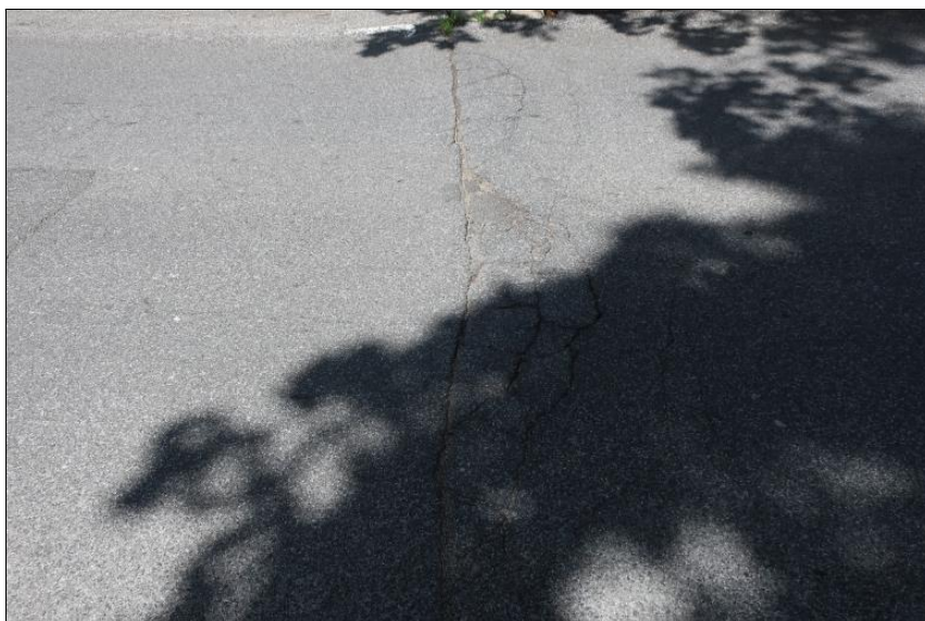
trhliny v krytu vozovky nad O1
