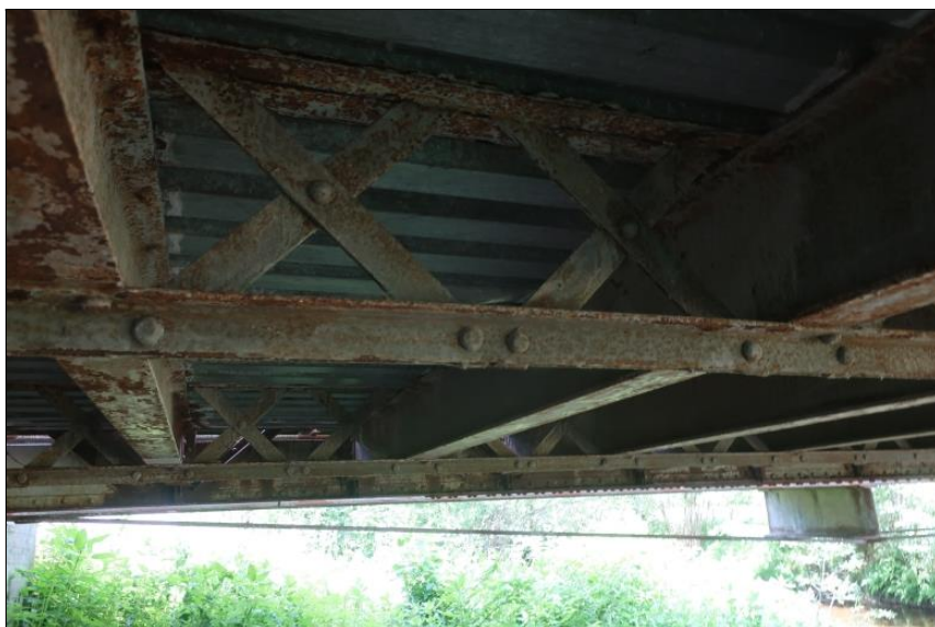
koroze mezilehlého podélníku
