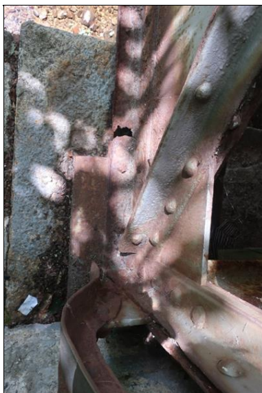
prerezlý spodní pás pravého hlavního nosníku u O2
