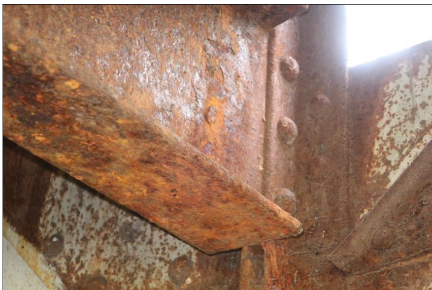
koroze styčnicku spodní pás hlavního nosníku - příčník
