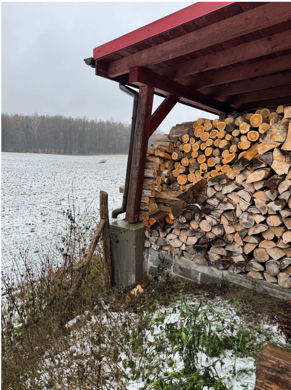
Uszkodzona stopa fundamentowa i słup drewniany
