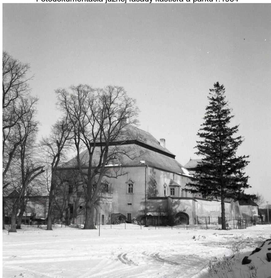
Fotodokumentácia južnej fasády kaštieľa a parku r.1964
