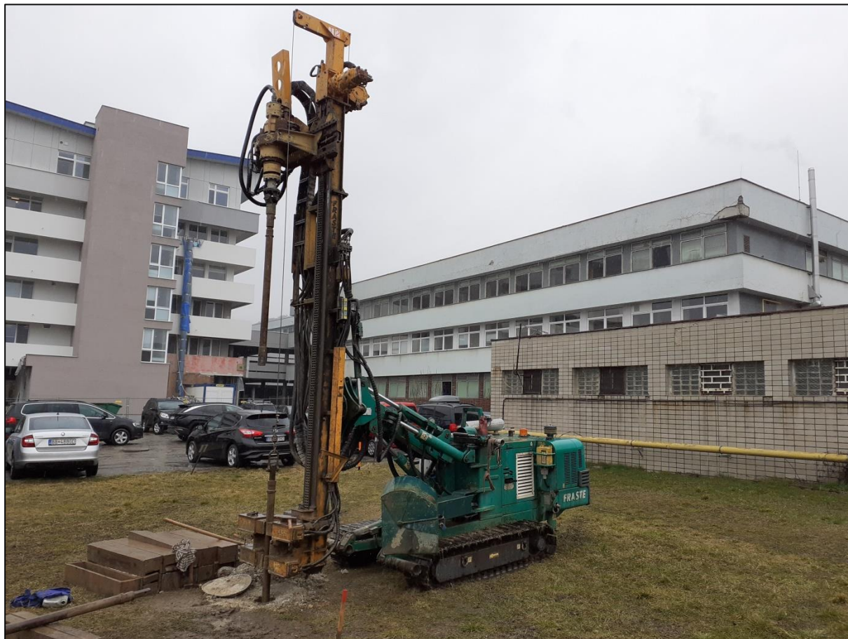
Obrázok č. 1: Vrtná súprava Fraste MITO-40 (vrt IGN-1), marec 2023.
