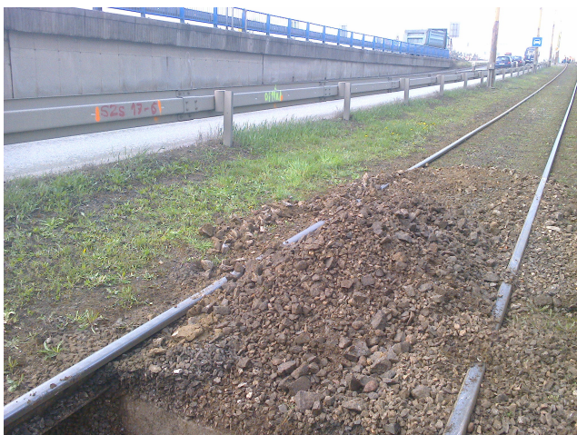
Obrázok 8 Koľajové kamenivo a podkladová štrková vrstva
