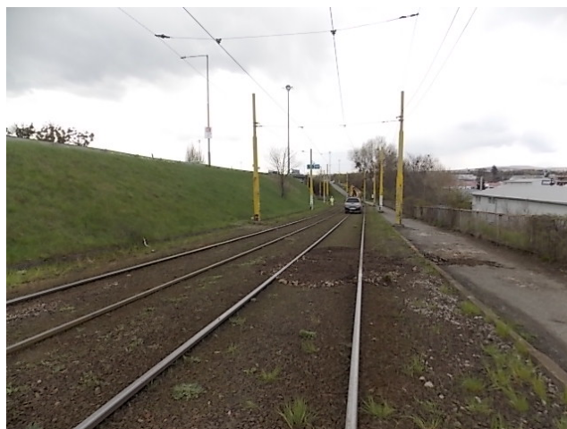
Obrázok 5 Koľajový zvršok tvorený otvorenou konštrukciou s koľajnicami na betónových podvaloch
