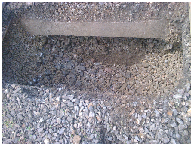
Obrázok 9 Zasypávanie sondy kamenivom počas výkopových prác
