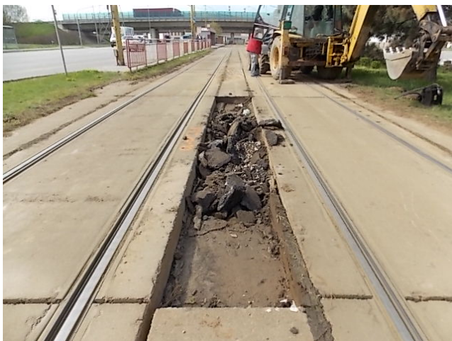
Obrázok 16 Kopaná sonda SZS17-10 po dočasnom odstránení stredového panela a rozbití asfaltovej vrstvy
