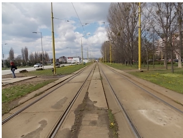
Obrázok 25 Koľajový zvršok tvorený panelmi s blokovými koľajnicami
