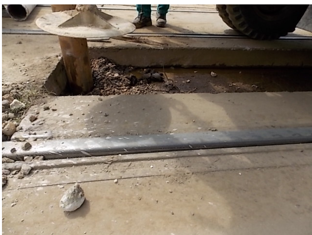
Obrázok 28 Vŕtanie vrtu UČS17-18 v osi trate po dočasnom odstránení stredového panela
