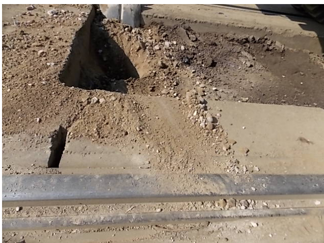
Obrázok 18 Miesto vrtanie vrtu UČS17-06 v osi trate
