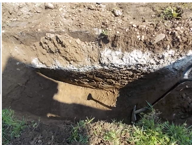
Obrázok 15 Kopaná sonda SZS17-11 pre statickú zaťažovaciu skúšku
