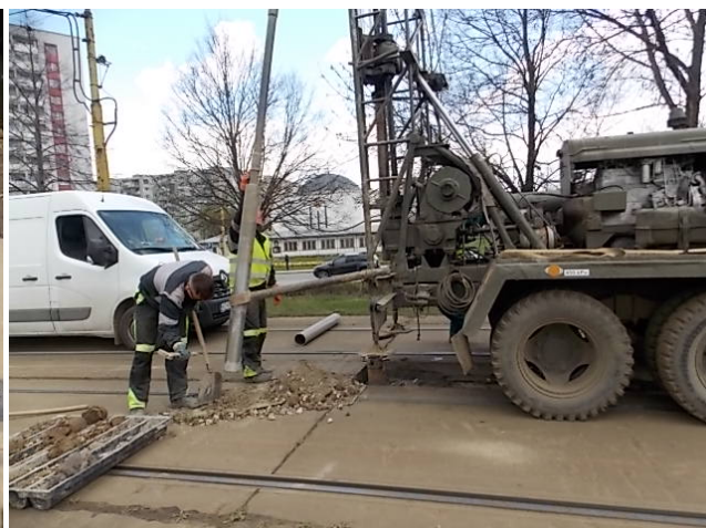
Obrázok 19 Vrt UČS17-16 po dočasnom odstránení stredového betónového panela
