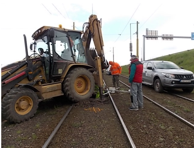
Obrázok 6 Kopaná sonda pred mostom nad železnicou
