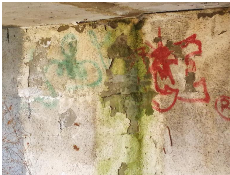
Obr.č.7: Jižní opěra – zatékání na líc opěry, degradace a trhlina v místě zatékání.
