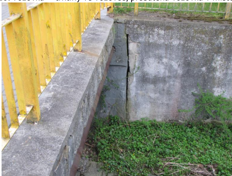
Obr.č.11: Jižní opěra - otevřená spára mezi opěrou a křídlem (nábrežní zdí).
