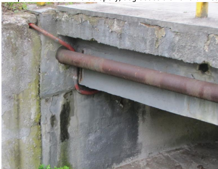
Obr.č.8: Severní opěra – odpad sanační omítky opěry, cizí chránička.
