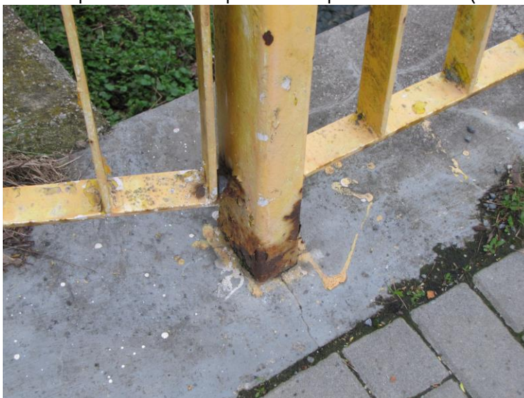
Obr.č.12: Severní opěra – prostupující koroze zábradlí přes PKO.
