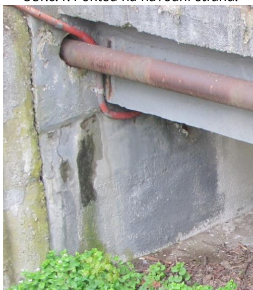
Obr.č.5: Fasádní nosník povodní strana – obnažená a korodující výztuž.
