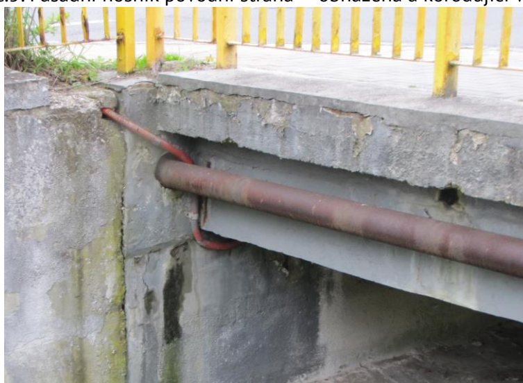
Obr.č.6: Římsa na povodní straně – odpad sanační omítky a degradace povrchu římsy.
