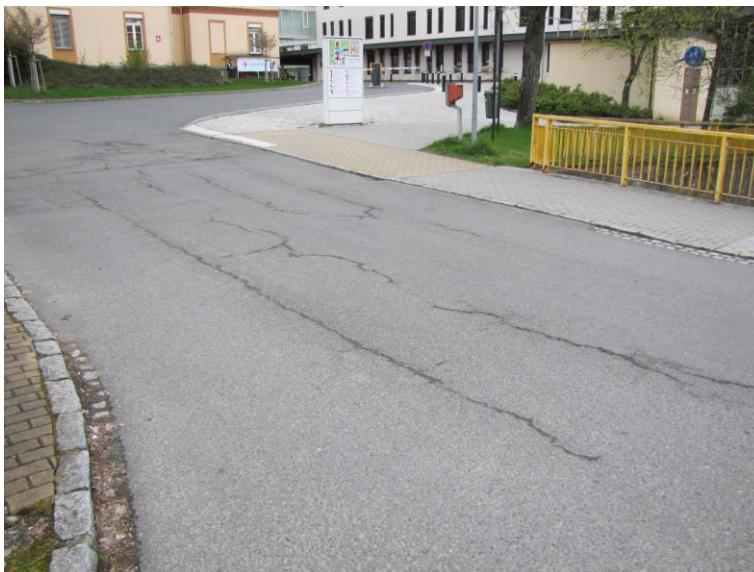
Obr.č.10: Vozovka – trhliny ve vozovce, přebalená vozovka v místě obrub.
