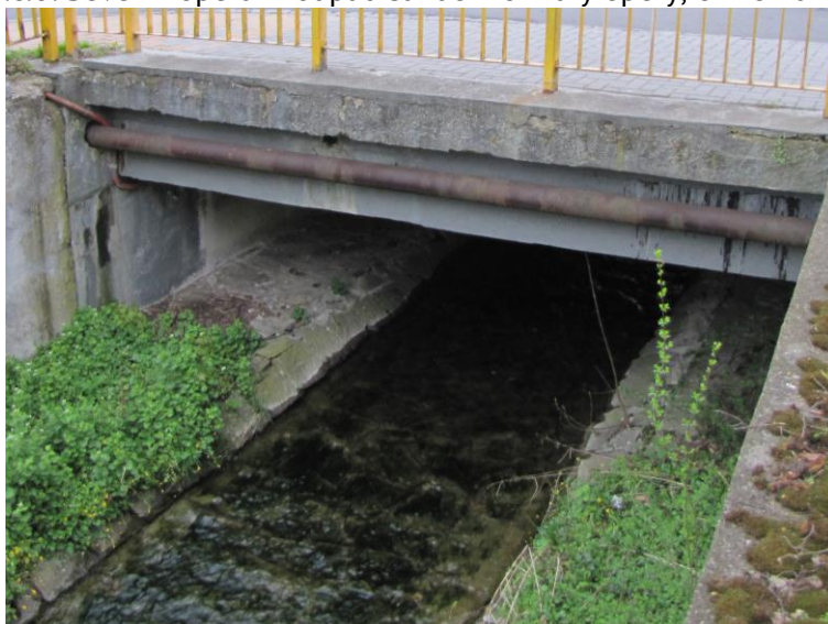
Obr.č.9: Lavice pod mostem – rozpad spárování kamenné dlažby.
