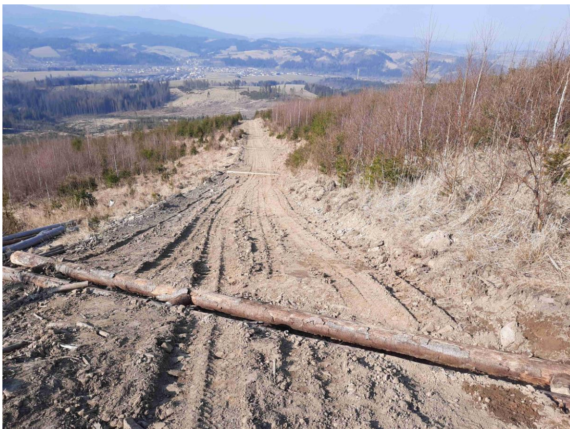
Obr. 2 Ukážka realizovaných drevených odrážok na zväžnici.
